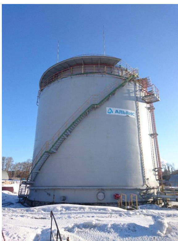
Рисунок 3 - Общий вид резервуара РВСПзс-3000
