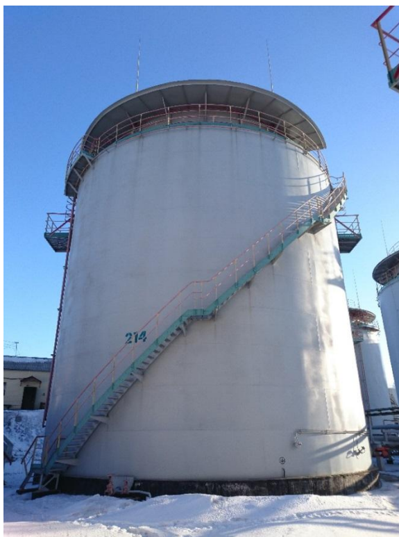
Рисунок 2 - Общий вид резервуара РВСПзс-2000
