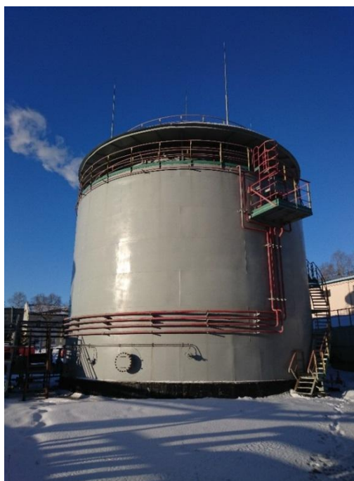
Рисунок 1 - Общий вид резервуара РВСПзс-1000
