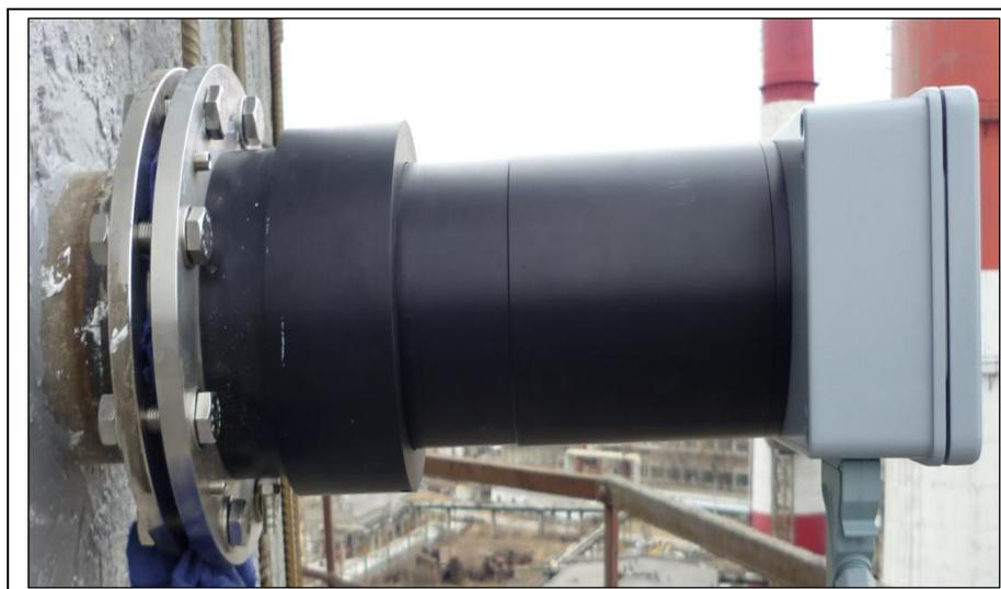
Рисунок 3 - Анализатор пыли LaserDust на месте установки
