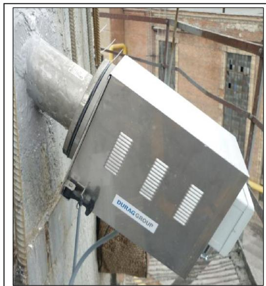
Рисунок 2 - Измеритель скорости потока D-FL-220 на месте установки
