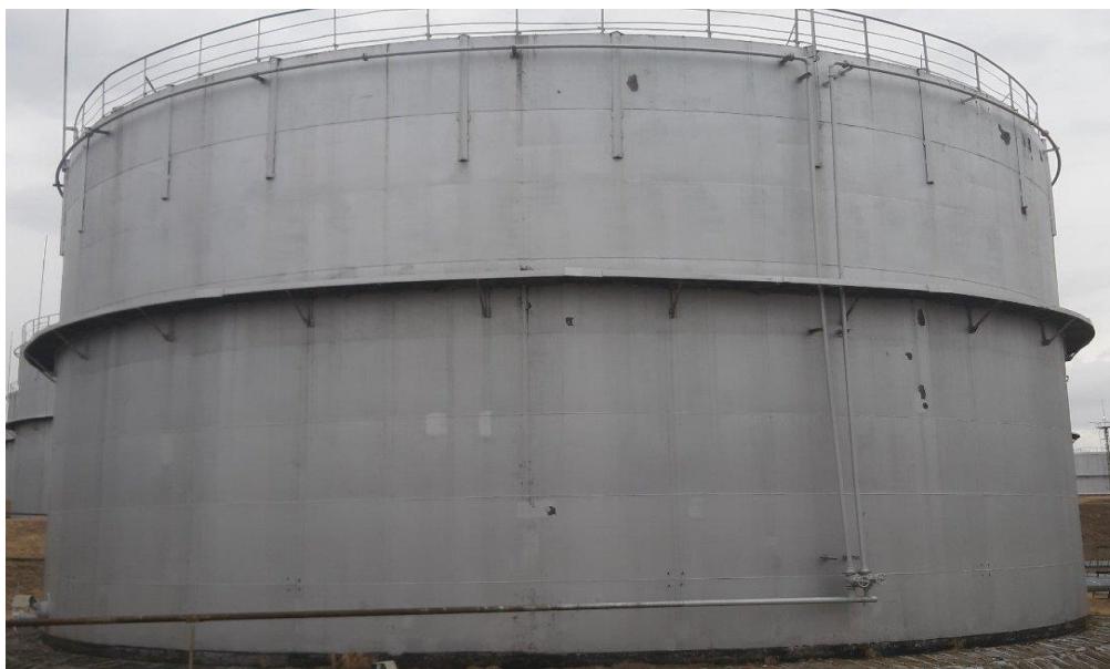
Рисунок 1 – Общий вид резервуаров стальных вертикальных цилиндрических РВС-5000
