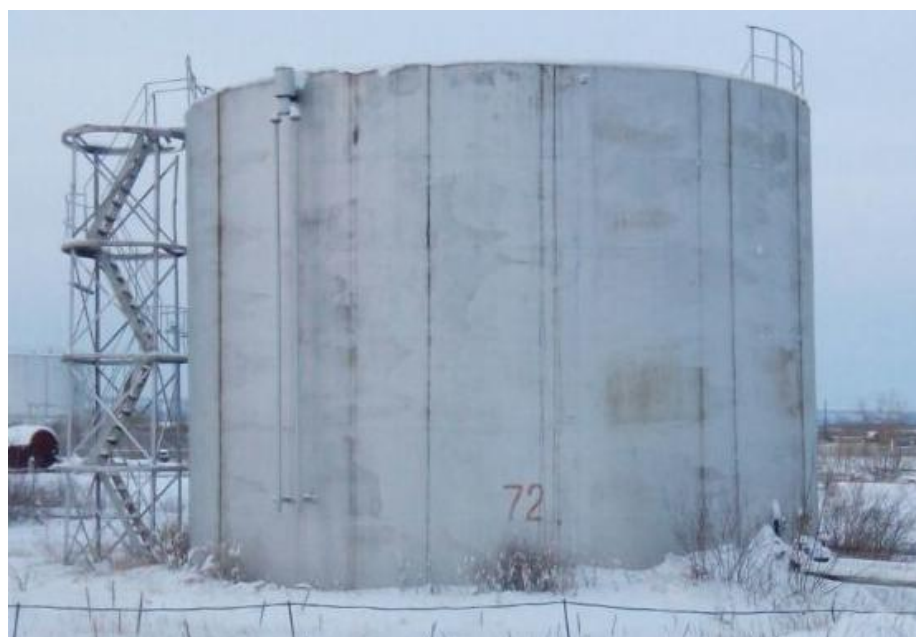
Рисунок 3 - Общий вид резервуара РВС-1000
