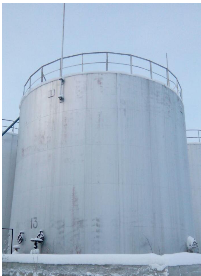
Рисунок 1 - Общий вид резервуара РВС-400
