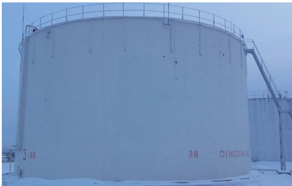
Рисунок 6 - Общий вид резервуара РВС-5000
