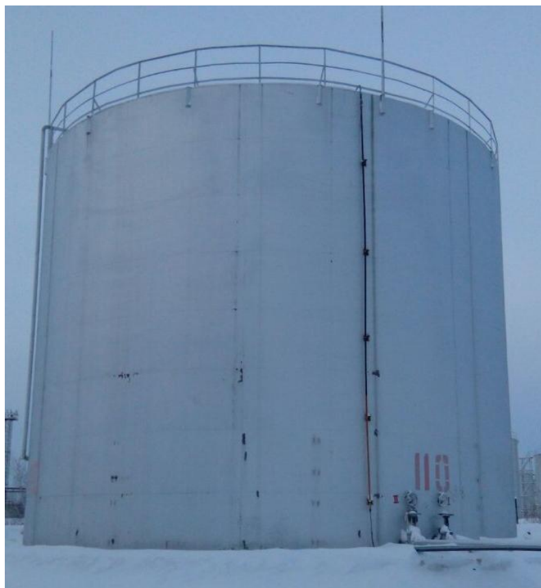
Рисунок 4 - Общий вид резервуара РВС-2000
