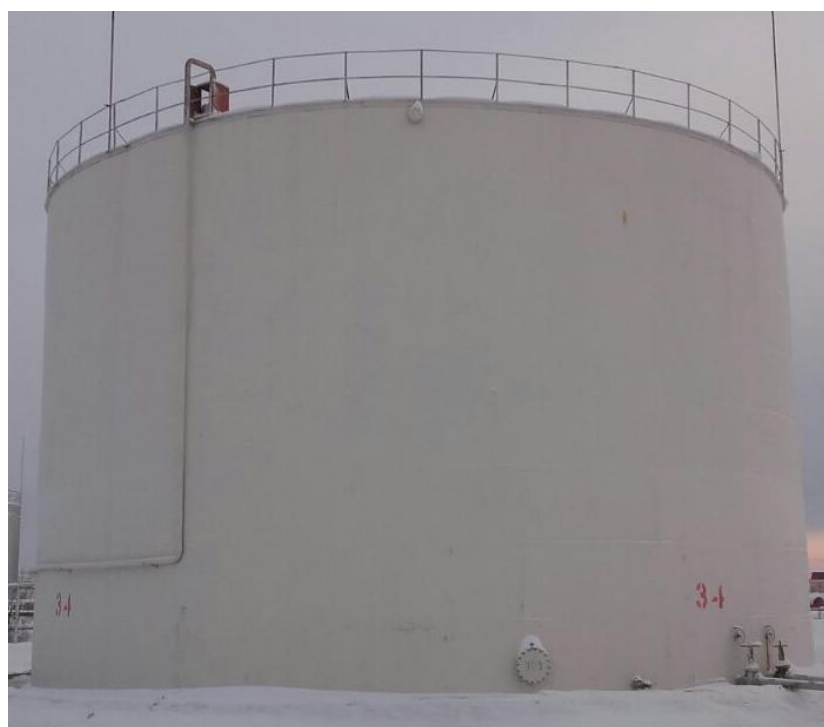
Рисунок 5 - Общий вид резервуара РВС-3000
