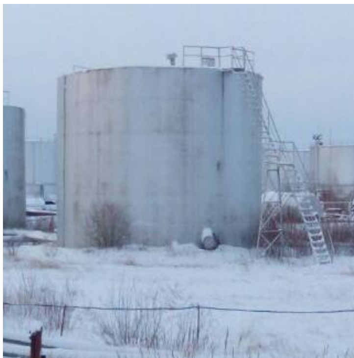
Рисунок 2 - Общий вид резервуара РВС-700
