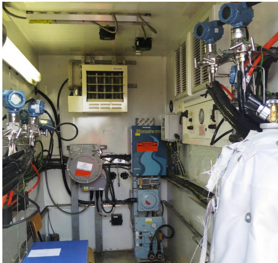
Рисунок 2 - Фотография средств измерений, расположенных в теплоизолированном боксе
