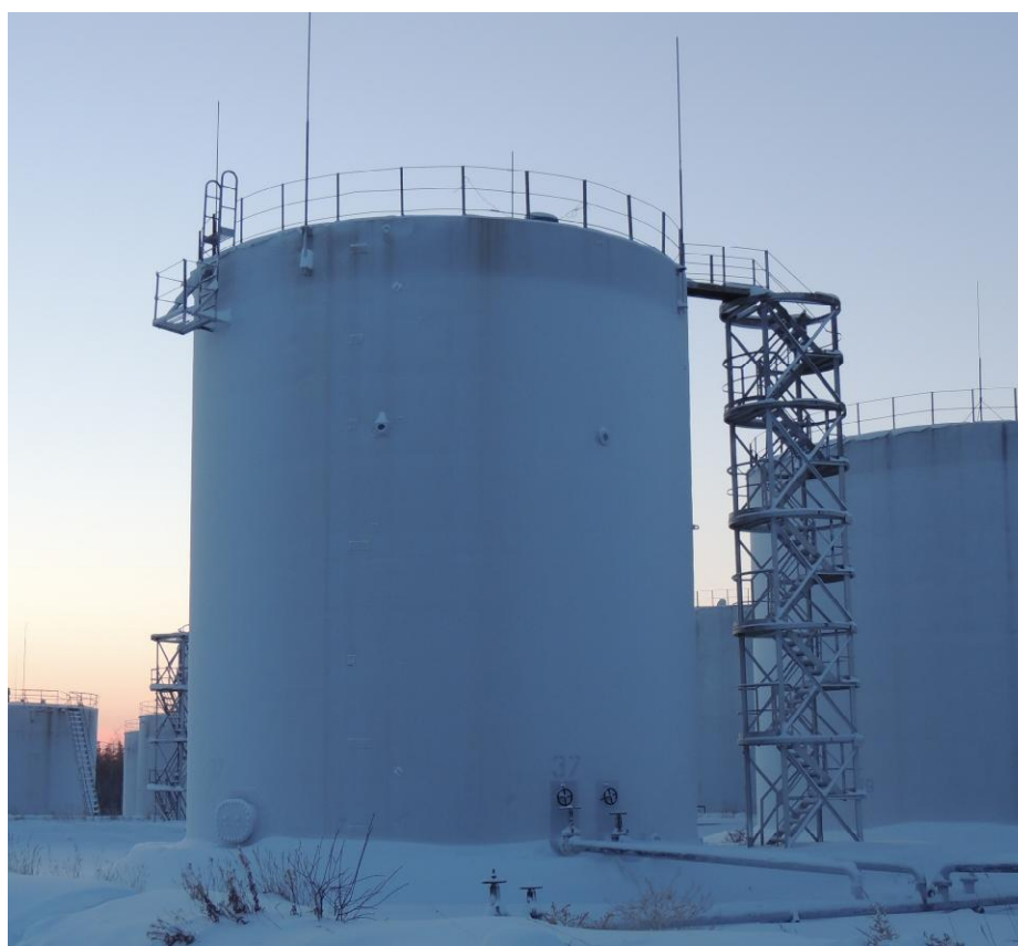
Рисунок 3 - Общий вид резервуара РВС-1000
