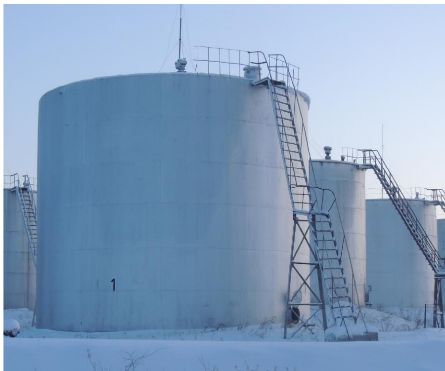
Рисунок 2 - Общий вид резервуара РВС-700
