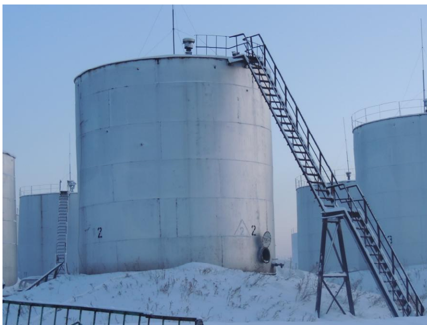
Рисунок 1 - Общий вид резервуара РВС-400
