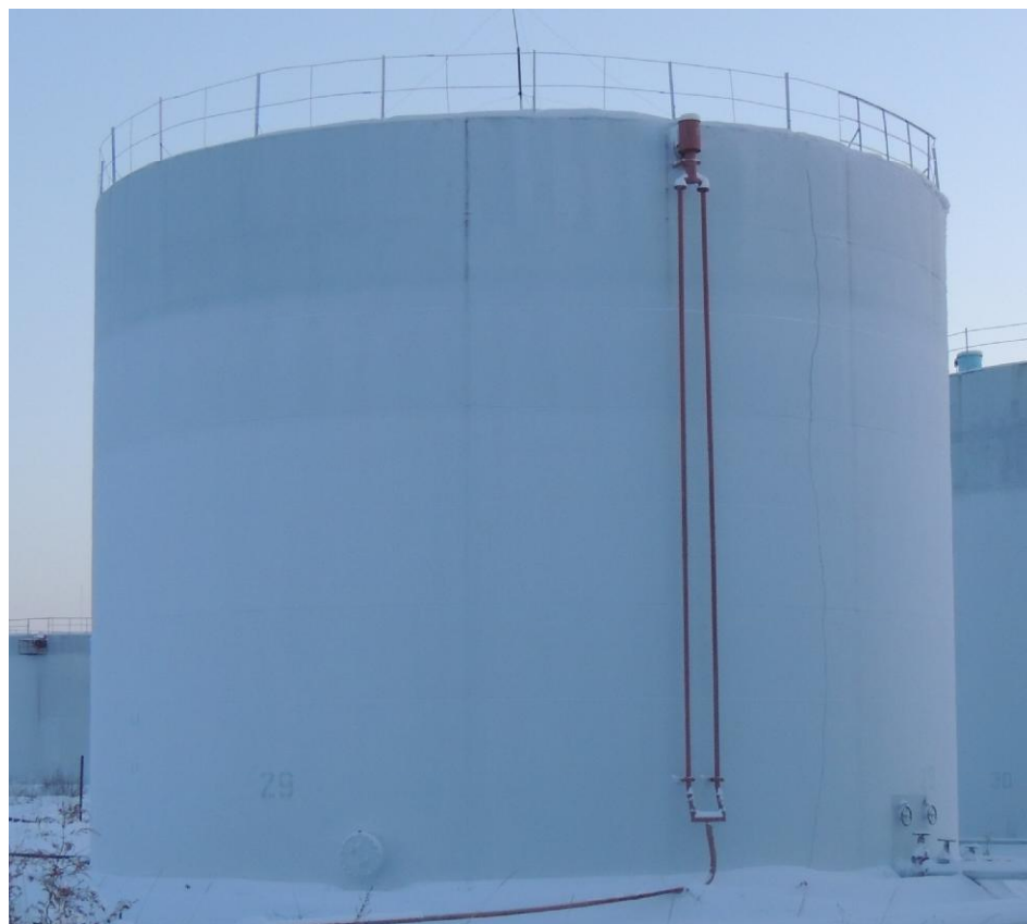
Рисунок 4 - Общий вид резервуара РВС-2000
