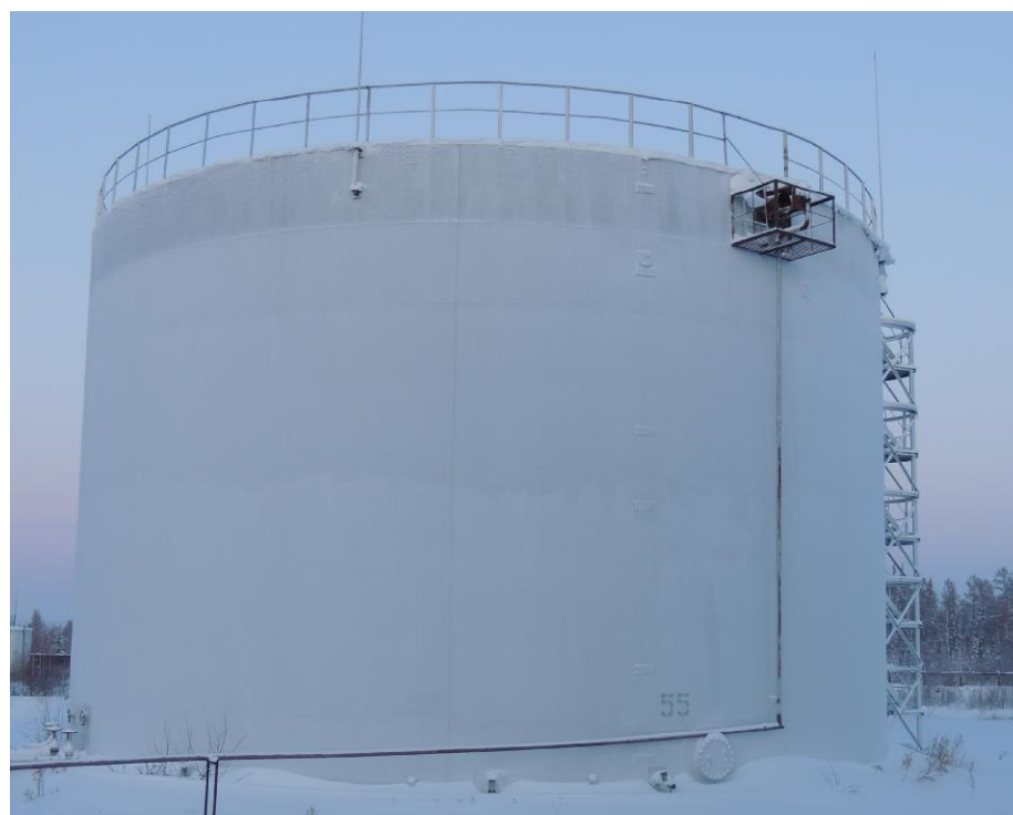
Рисунок 5 - Общий вид резервуара РВС-3000
