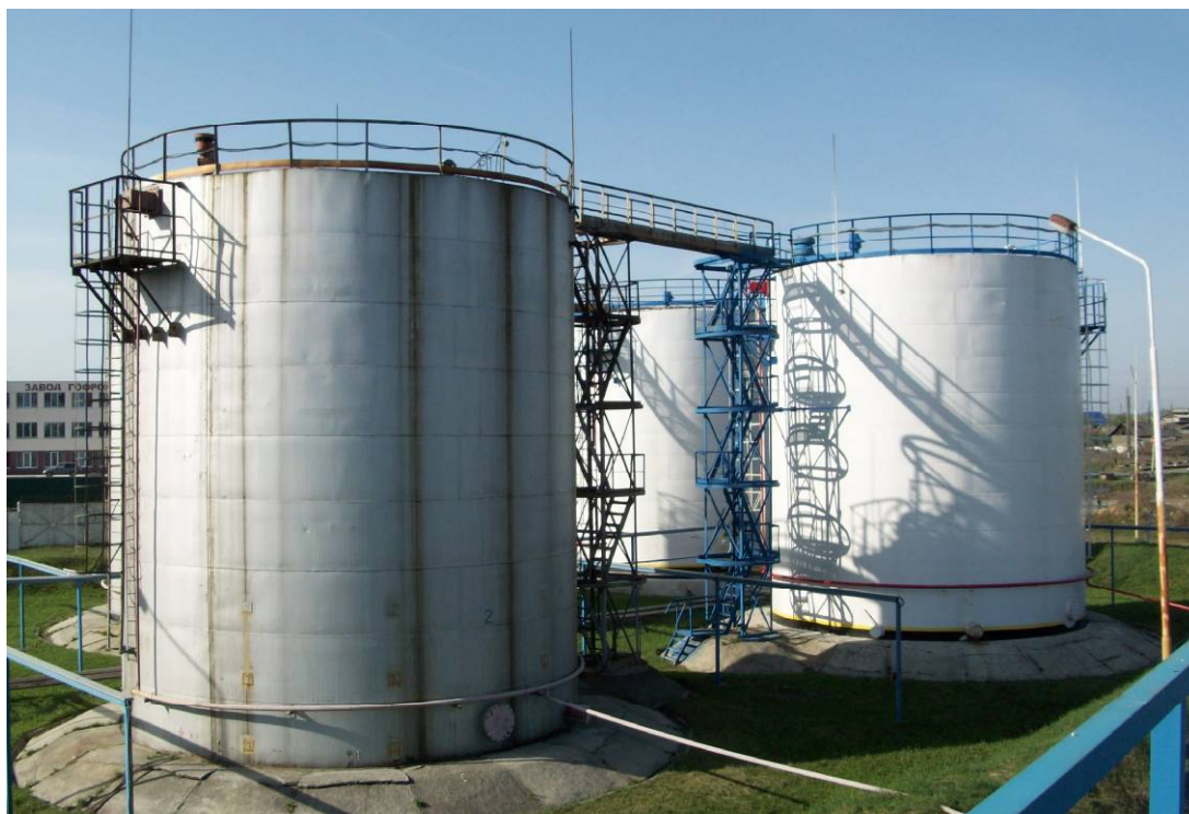
Рисунок 1 - Общий вид резервуара вертикального стального цилиндрического РВС-1000
