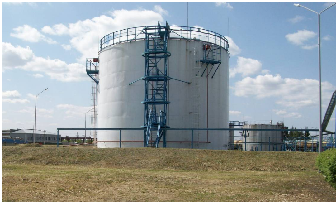
Рисунок 2 - Общий вид резервуара вертикального стального цилиндрического РВСП-2000
