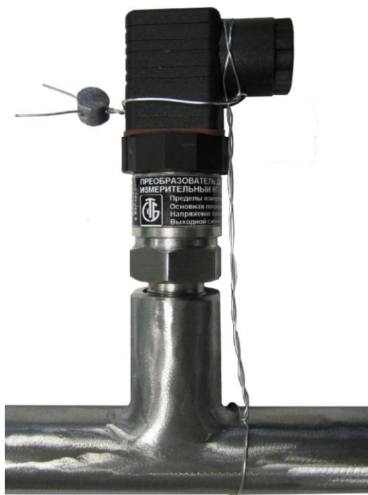
Рисунок 2 - Схема пломбировки преобразователей давления измерительных НТ
