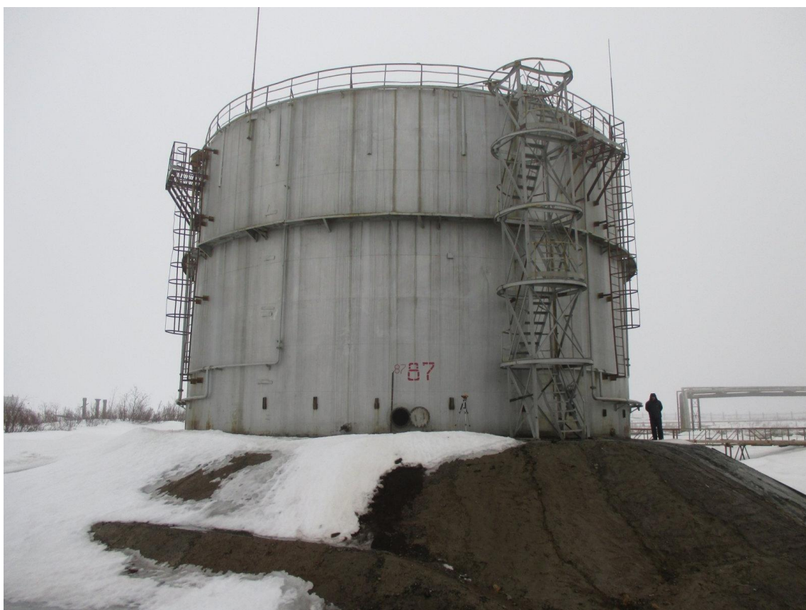
Рисунок 2 - Общий вид резервуара вертикального стального цилиндрического РВС-5000
