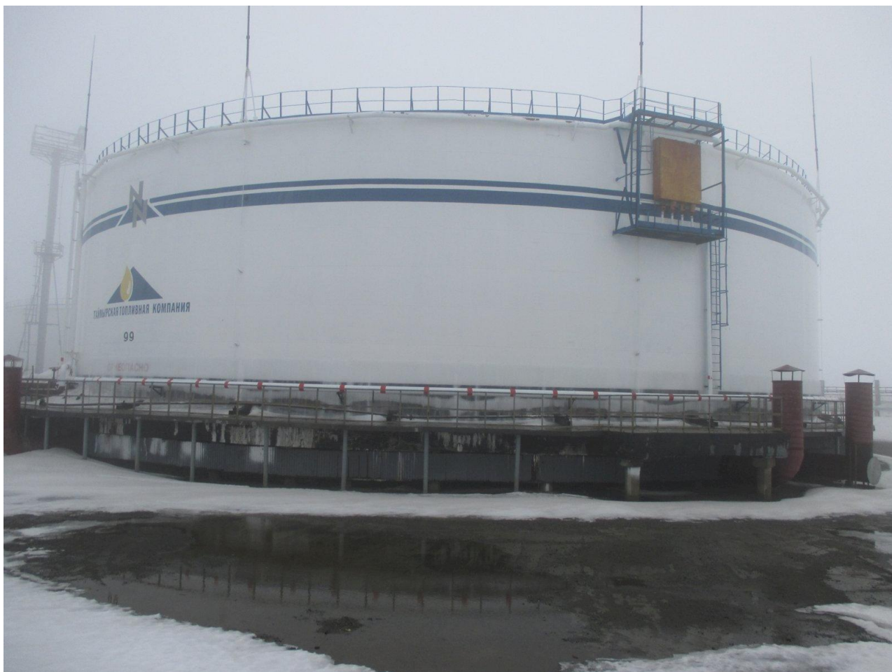
Рисунок 3 - Общий вид резервуара вертикального стального цилиндрического РВС-20000
