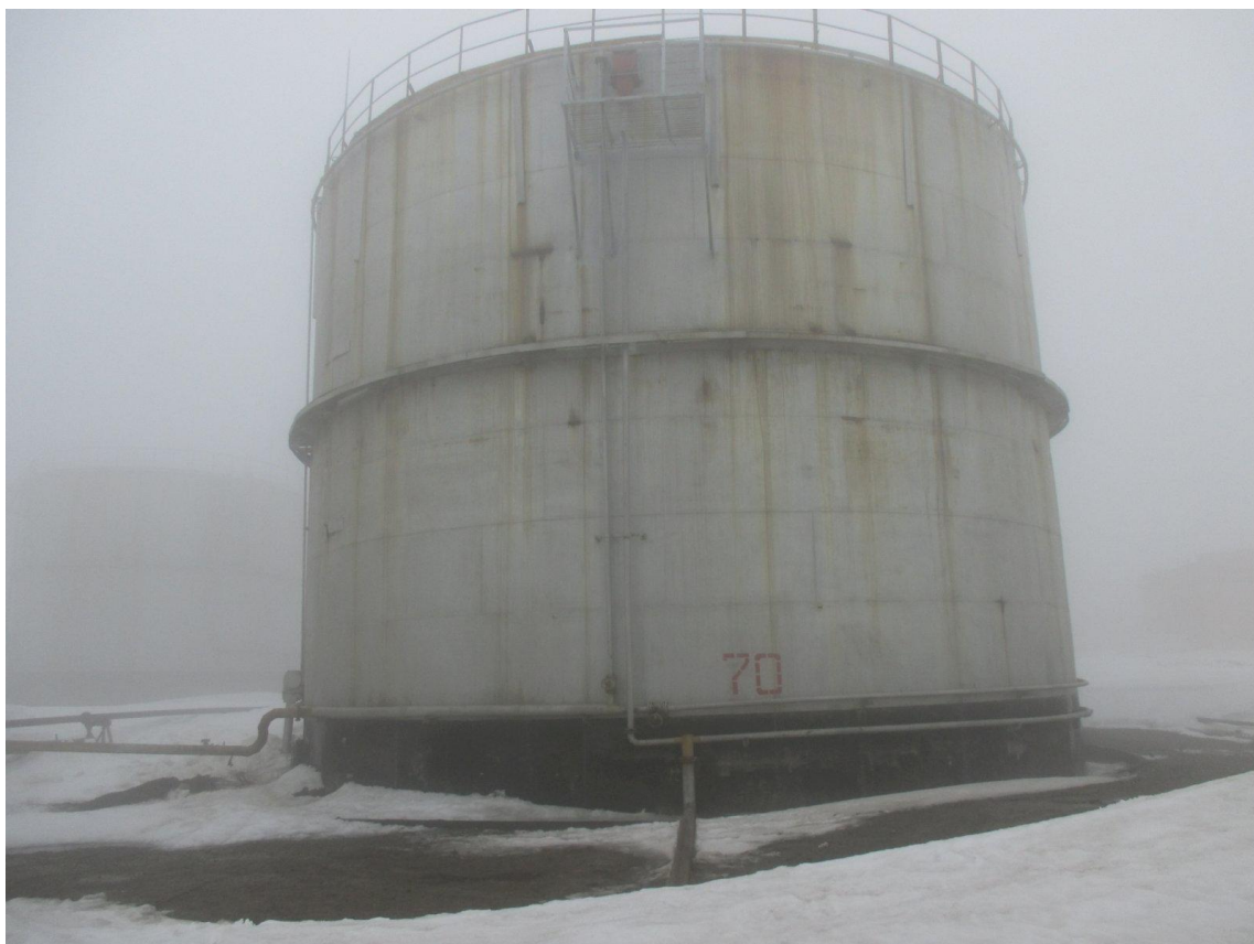
Рисунок 1 - Общий вид резервуара вертикального стального цилиндрического РВС-2000
