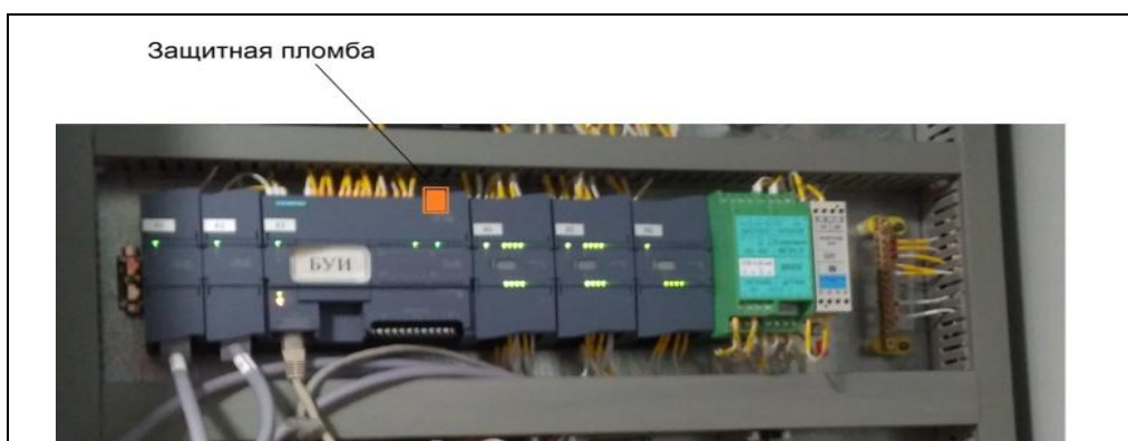
Рисунок 2 - Место пломбировки контроллера БУИ
