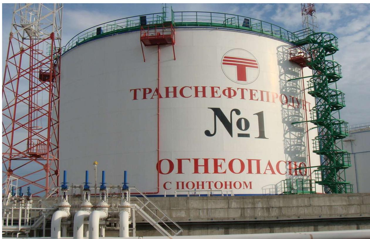
Рисунок 4 - Общий вид резервуара вертикального стального цилиндрического РВСП-10000
