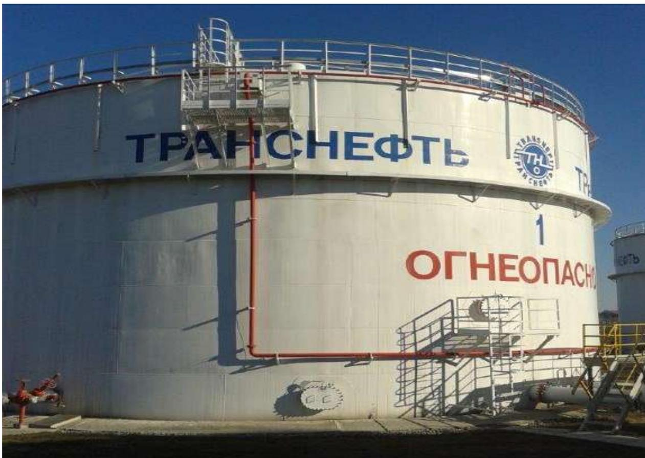
Рисунок 3 - Общий вид резервуара вертикального стального цилиндрического РВСП-5000
