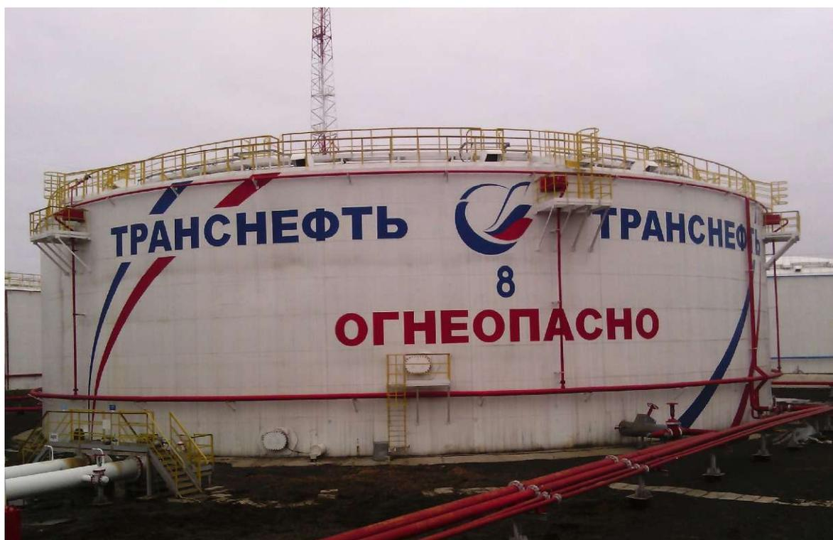
Рисунок 5 - Общий вид резервуара вертикального стального цилиндрического РВСП-20000
