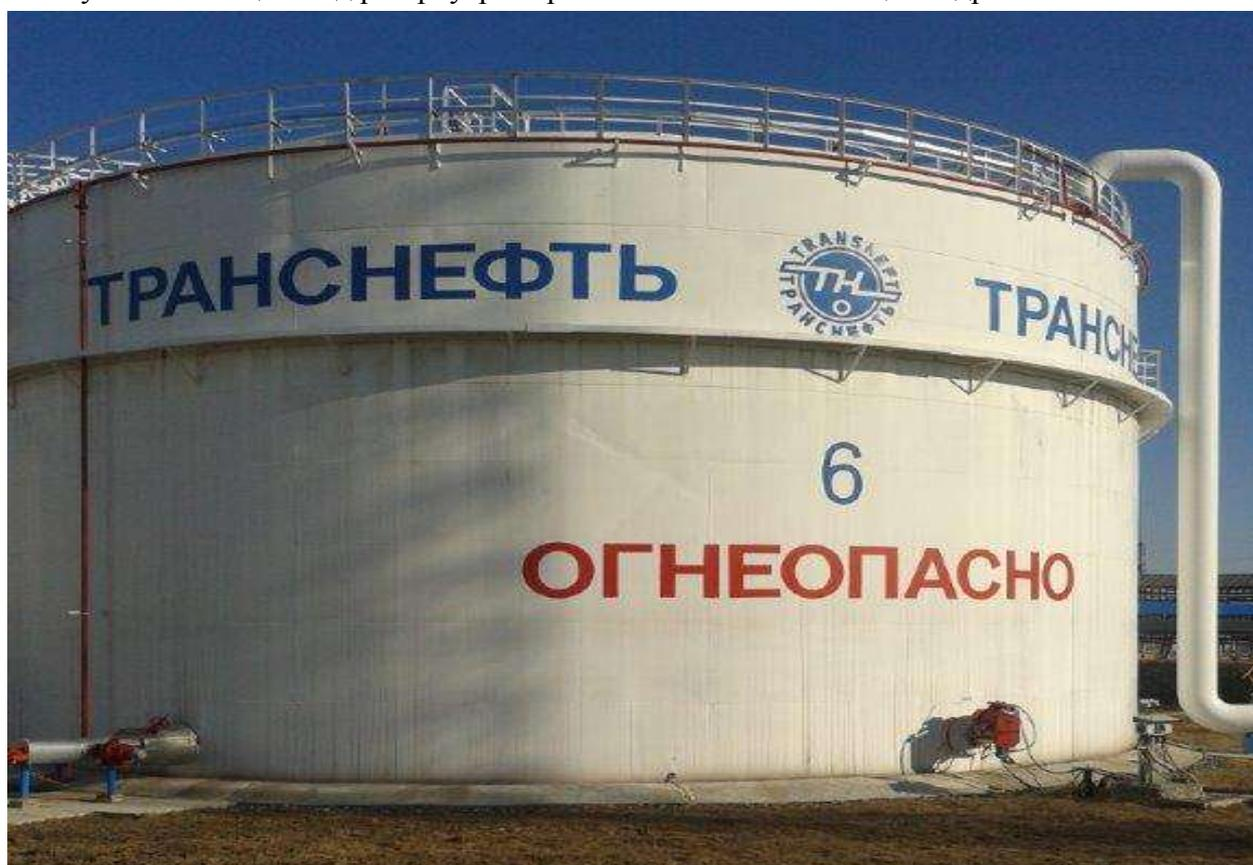
Рисунок 2 - Общий вид резервуара вертикального стального цилиндрического РВС-5000
