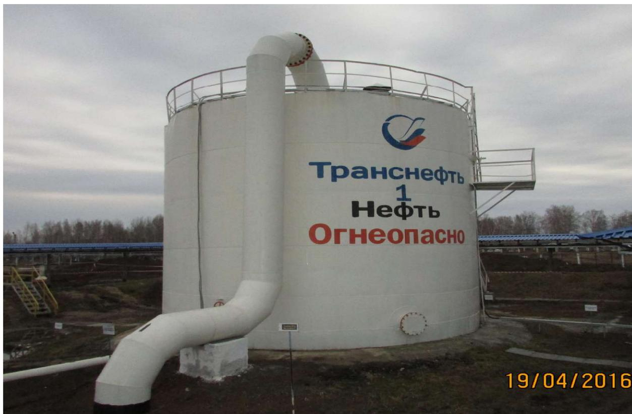
Рисунок 1 - Общий вид резервуара вертикального стального цилиндрического РВС-400
