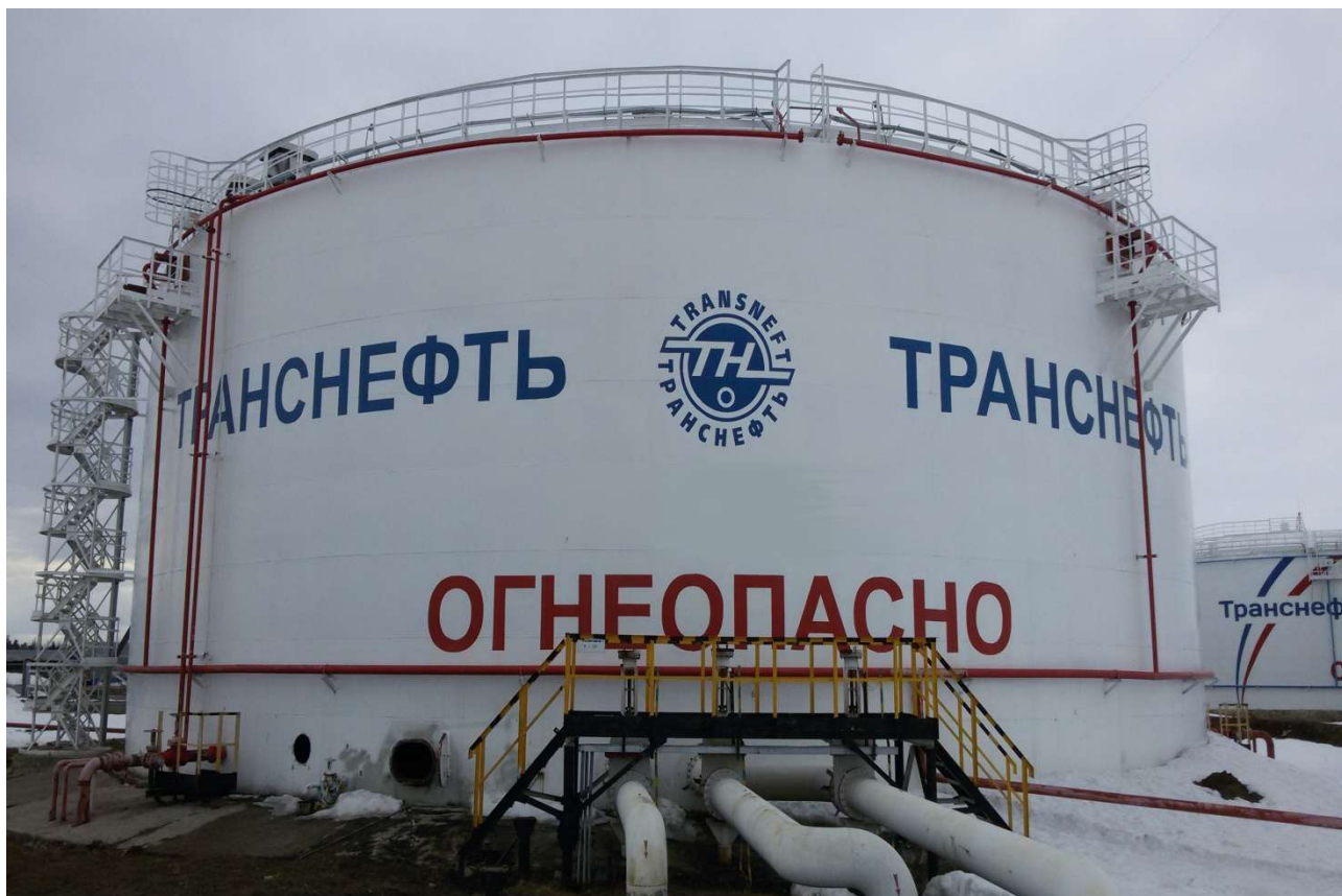
Рисунок 4 - Общий вид резервуара вертикального стального цилиндрического РВС-10000
