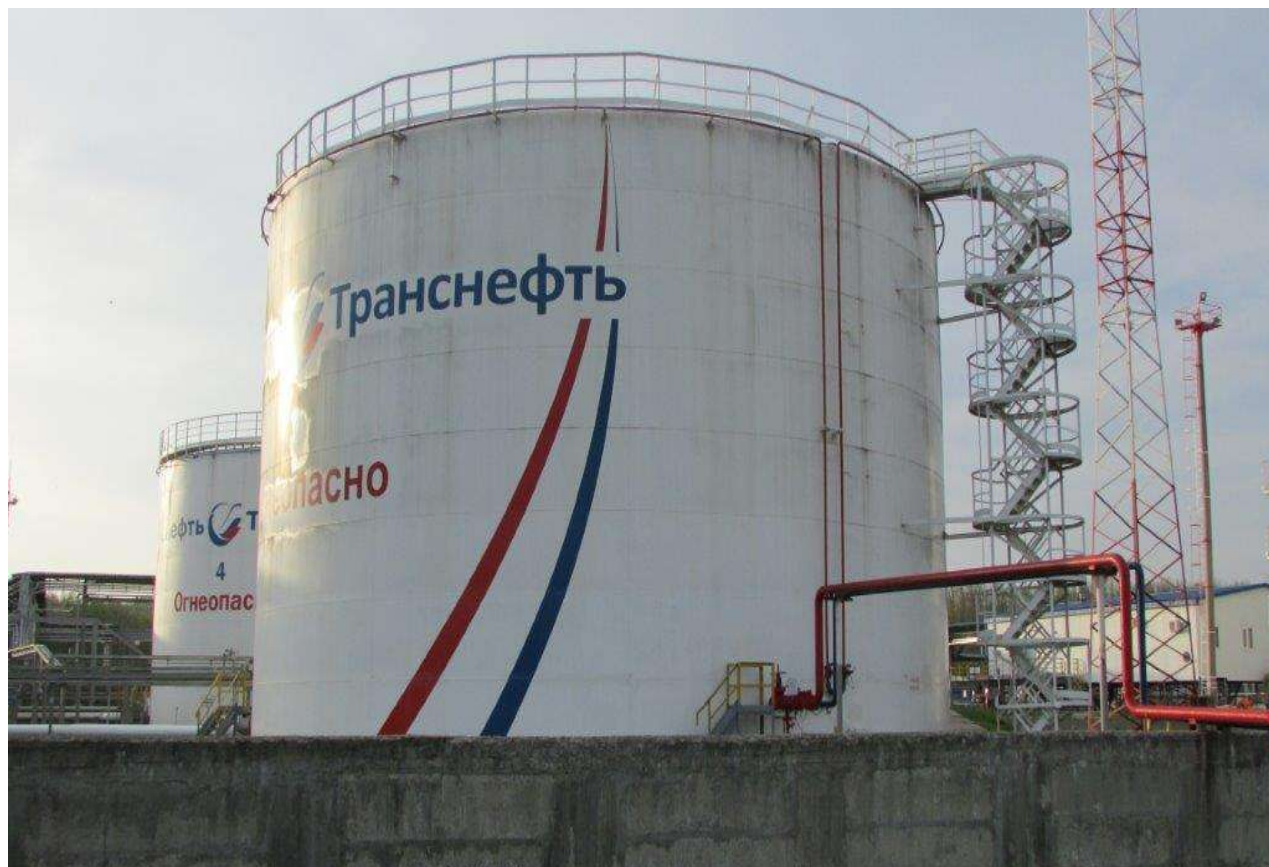
Рисунок 2 - Общий вид резервуара вертикального стального цилиндрического РВС-3000
