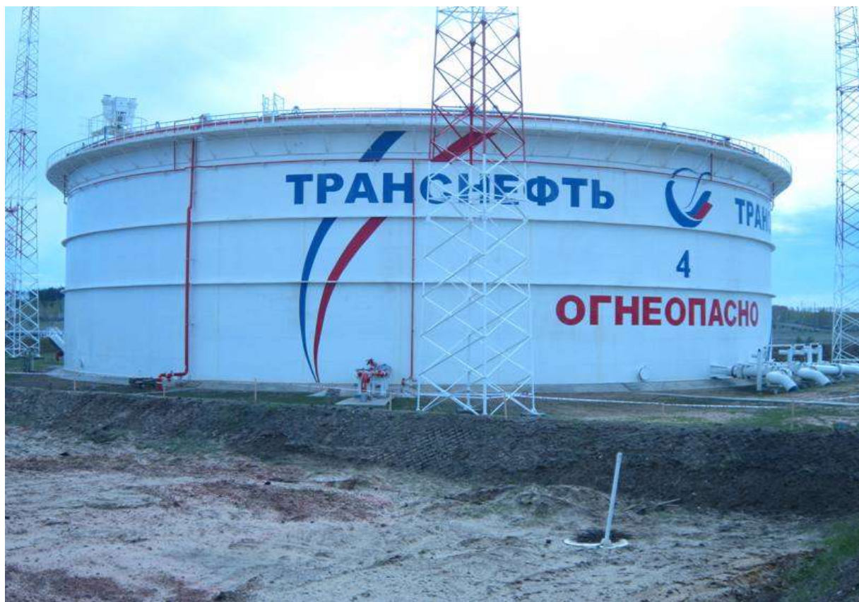
Рисунок 7 - Общий вид резервуара вертикального стального цилиндрического РВСПК-50000
