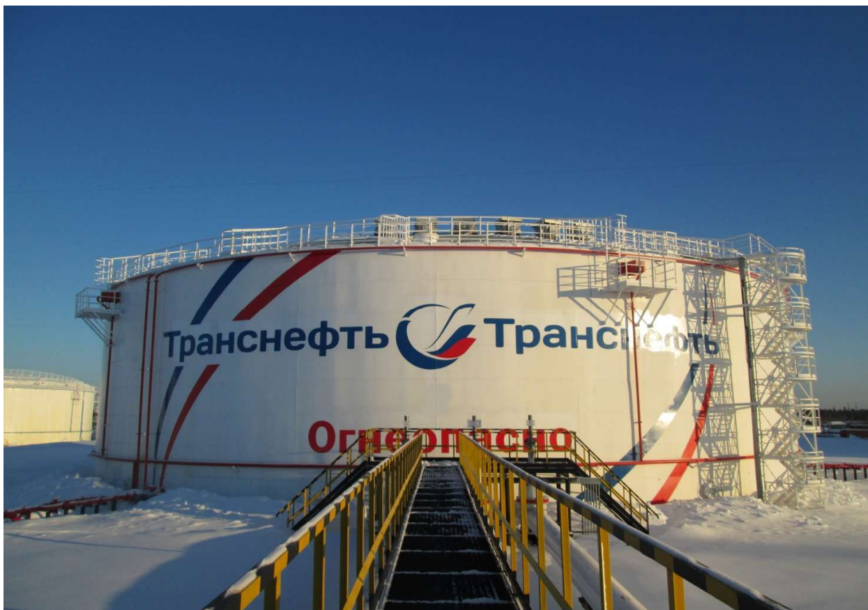
Рисунок 6 - Общий вид резервуара вертикального стального цилиндрического РВС-20000
