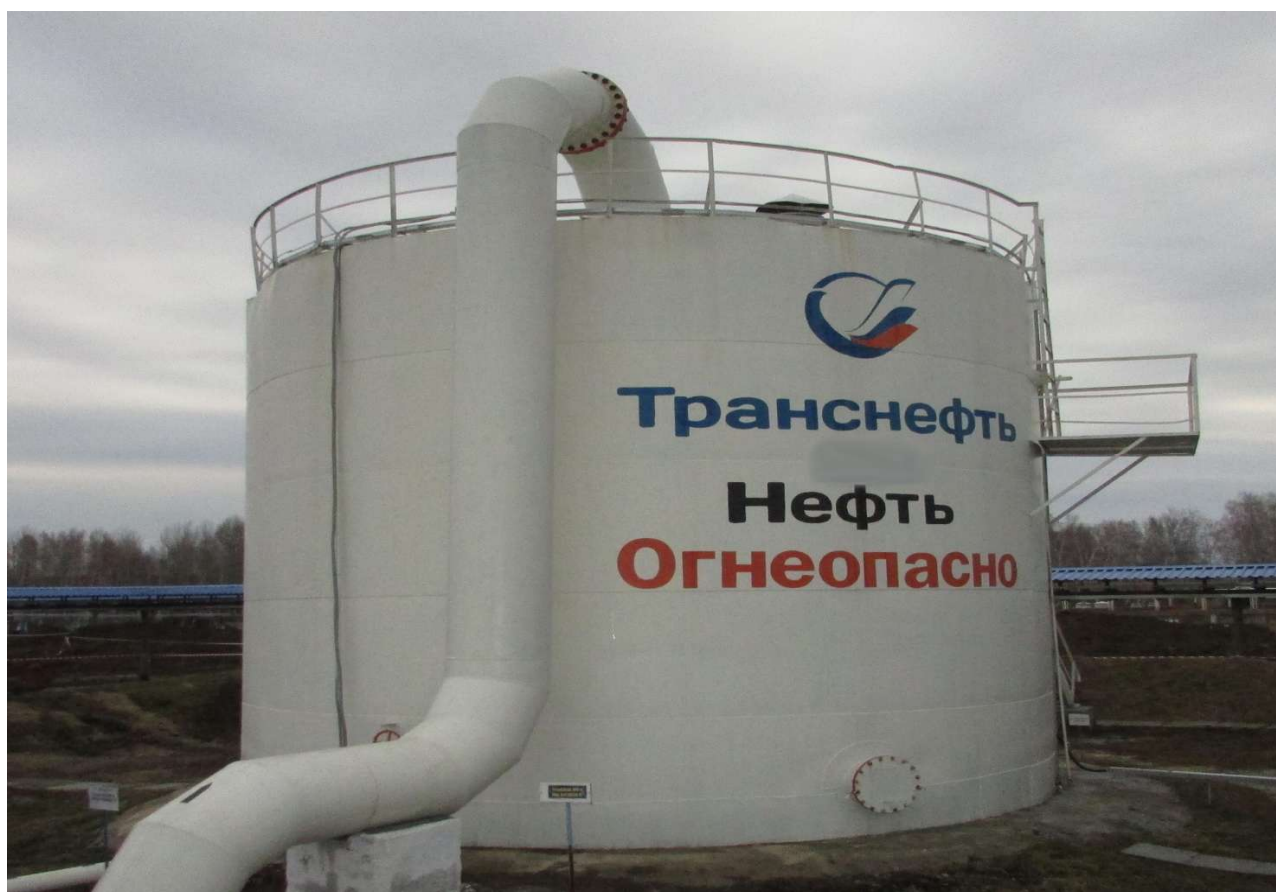
Рисунок 1 - Общий вид резервуара вертикального стального цилиндрического РВС-400
