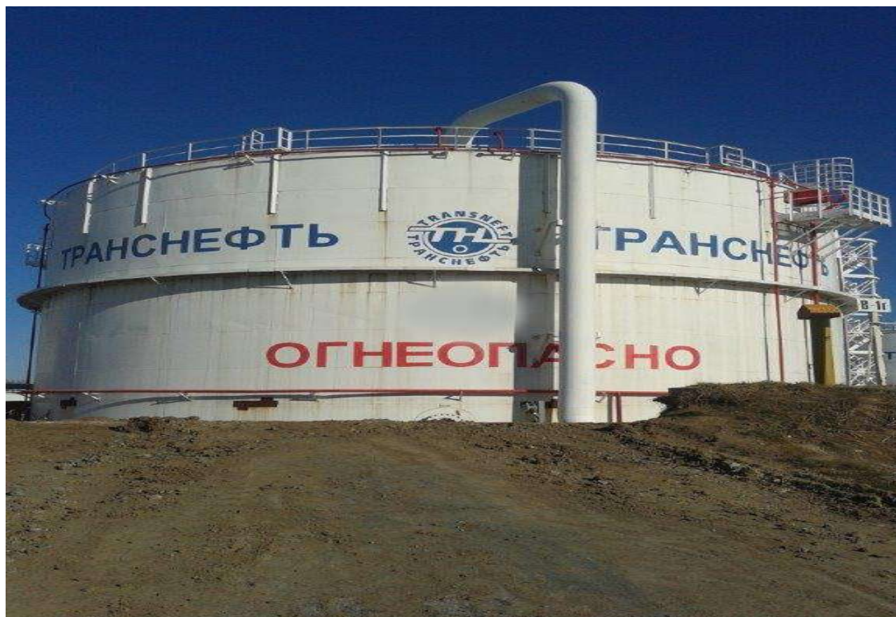
Рисунок 3 - Общий вид резервуара вертикального стального цилиндрического РВС-7500
