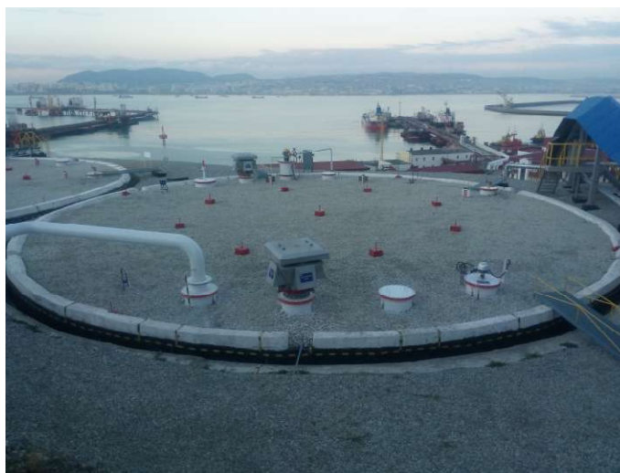
Рисунок 1 - Общий вид резервуара
