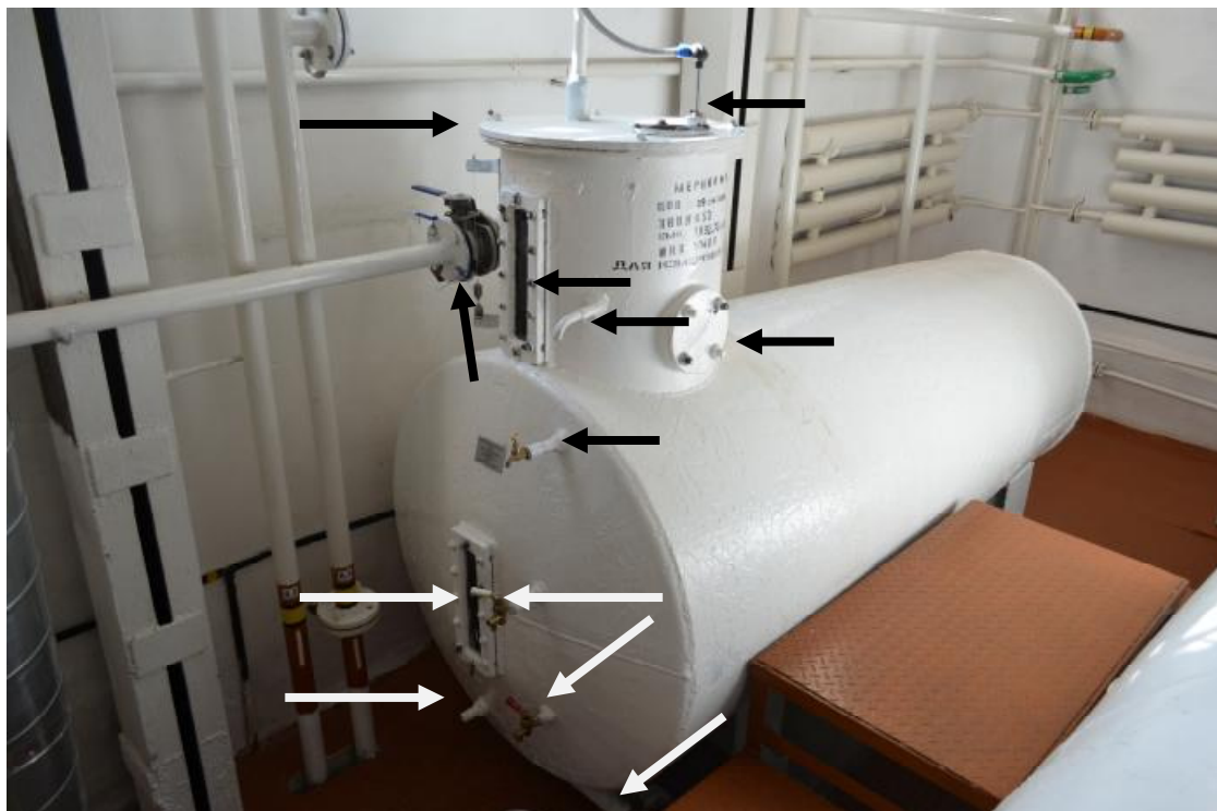
Рисунок 1 - Общий вид и места пломбирования мерника
