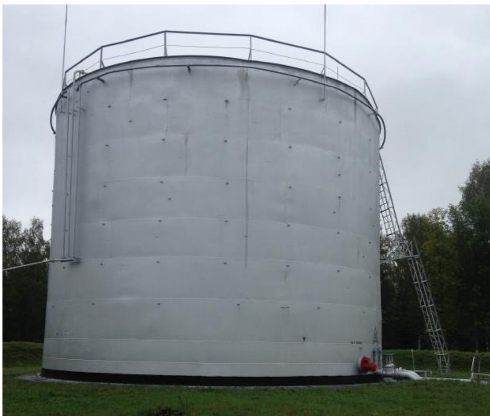
Рисунок 1 - Общий вид резервуара стального вертикального цилиндрического РВС-2000
