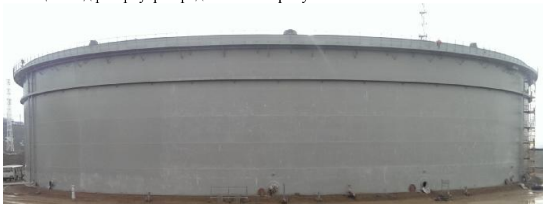
Рисунок 1 - общий вид резервуара
