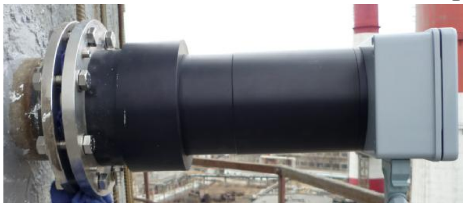
Рисунок 3 - Анализатор пыли LaserDust на месте установки (показан только один из двух блоков)
