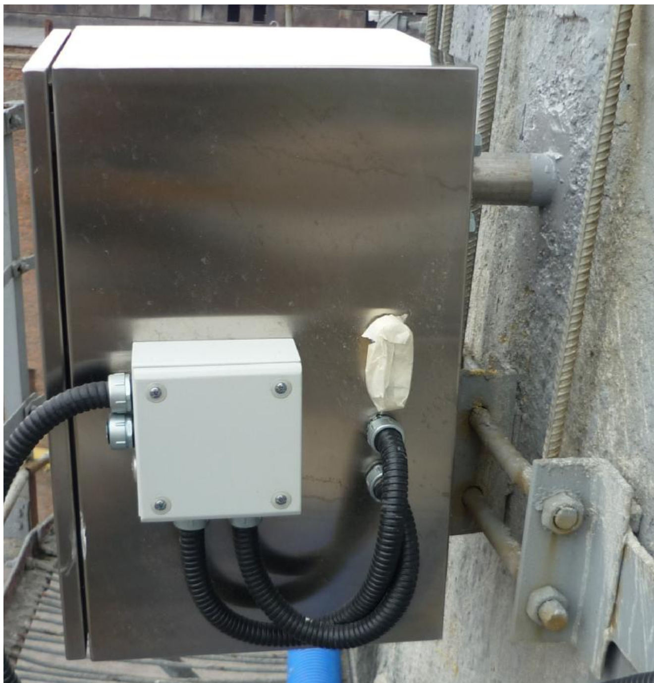
Рисунок 5 - Внешний вид пробоотборного зонда
