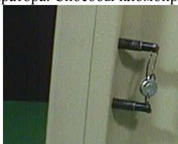
Рисунок 3 - Способ пломбировки контроллеров AccuLoad III
