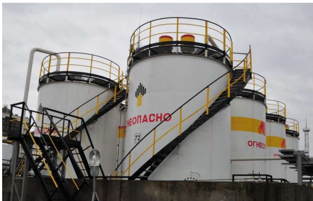
Рисунок 1 - Общий вид резервуаров
