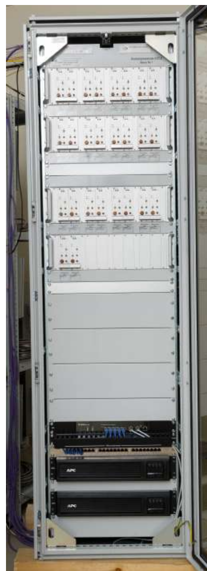
Рисунок 3 - Внешний вид стойки питания
