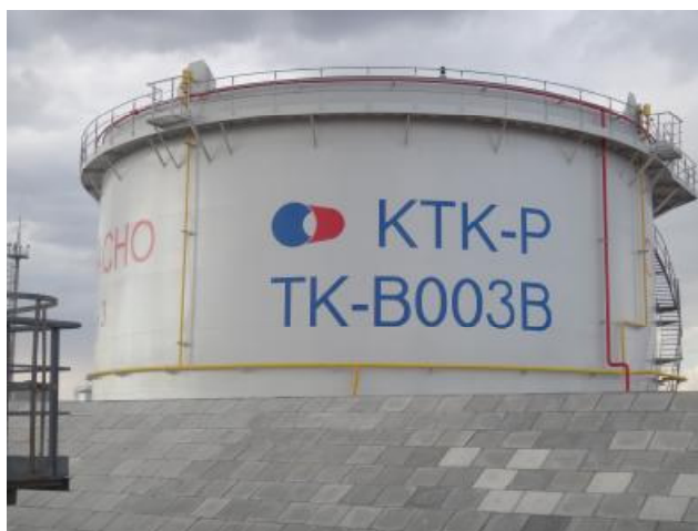
Рисунок 1 – Общий вид резервуара
