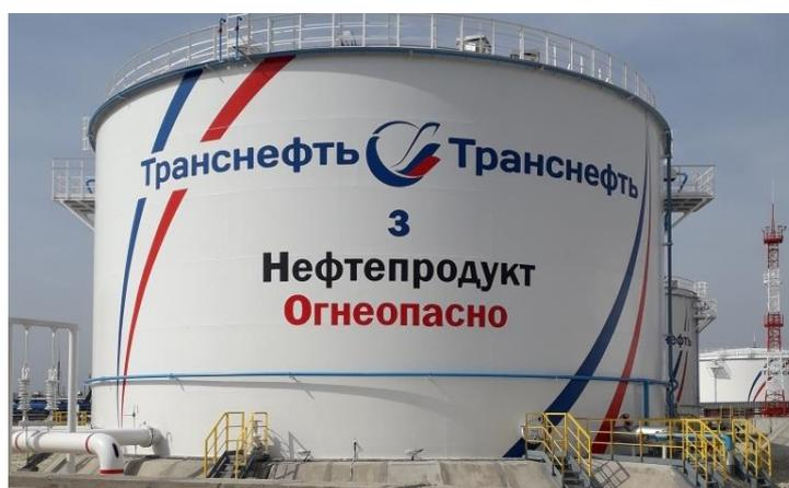
Рисунок 3 – Общий вид резервуара стального вертикального цилиндрического модификации РВС-5000 с заводским номером 3
