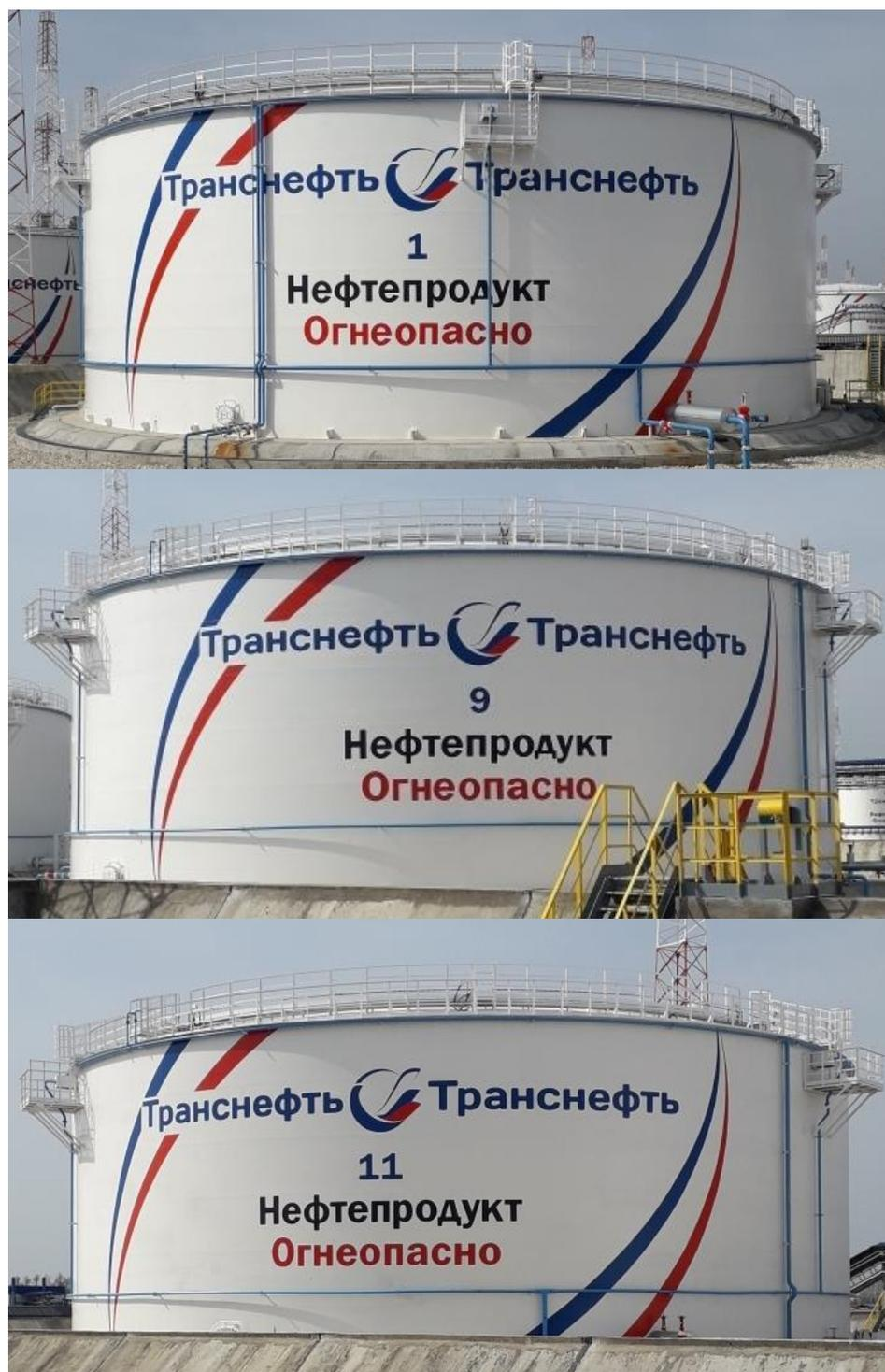
Рисунок 4 – Общий вид резервуаров стальных вертикальных цилиндрических модификации РВС-10000 с заводскими номерами 1, 9, 11
