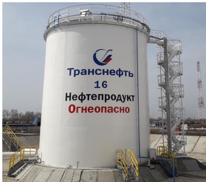
Рисунок 1 – Общий вид резервуара стального вертикального цилиндрического модификации РВС-1000 с заводским номером 16
