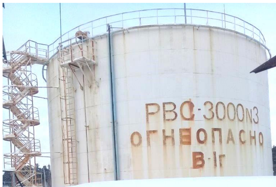
Рисунок 1 – Общий вид резервуара
