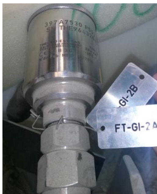
Рисунок 1 - Внешний вид преобразователя термоэлектрического с двумя термопарами ТЭС
