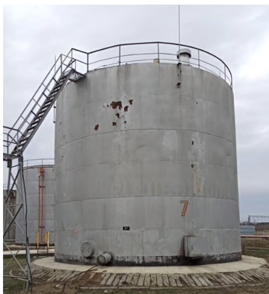
Рисунок 1 – Общий вид резервуаров стальных вертикальных цилиндрических РВС-700
