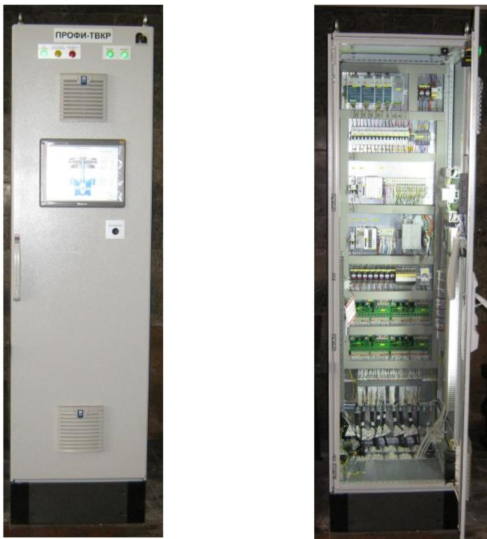
Рисунок 1 – Внешний вид системы температурного и вибрационного контроля «ПРОФИ-ТВКР»
