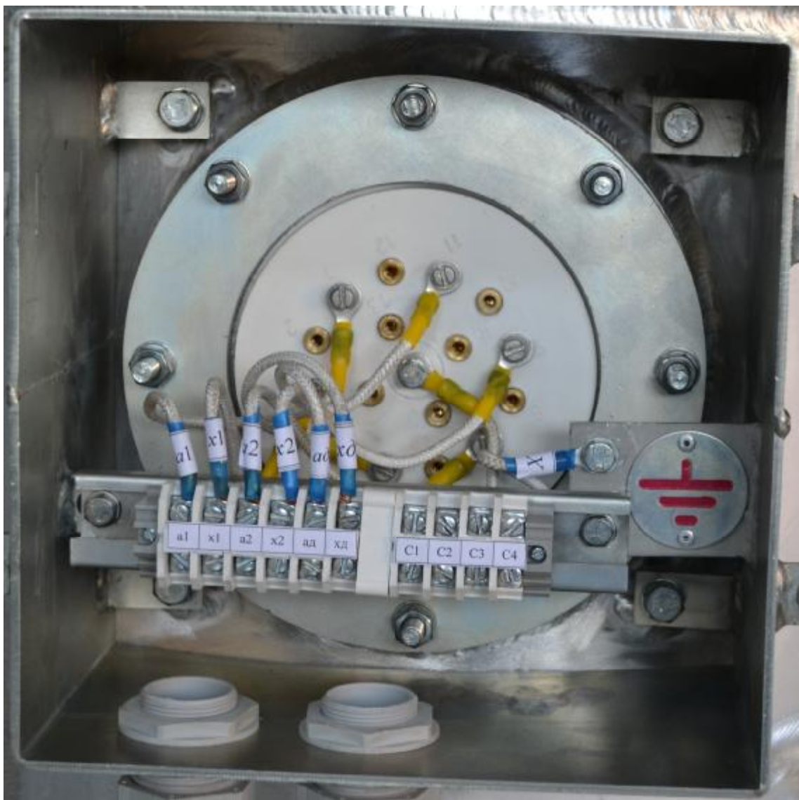
Рисунок 2. Клеммная коробка
