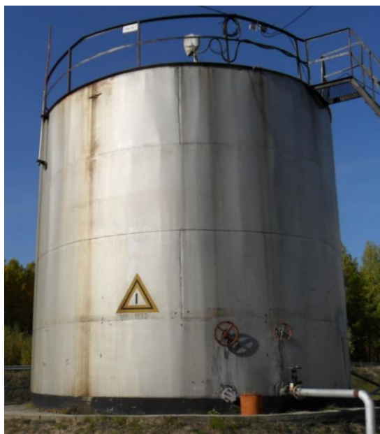
Рисунок 1 – Общий вид резервуаров стальных вертикальных цилиндрических РВС-200
