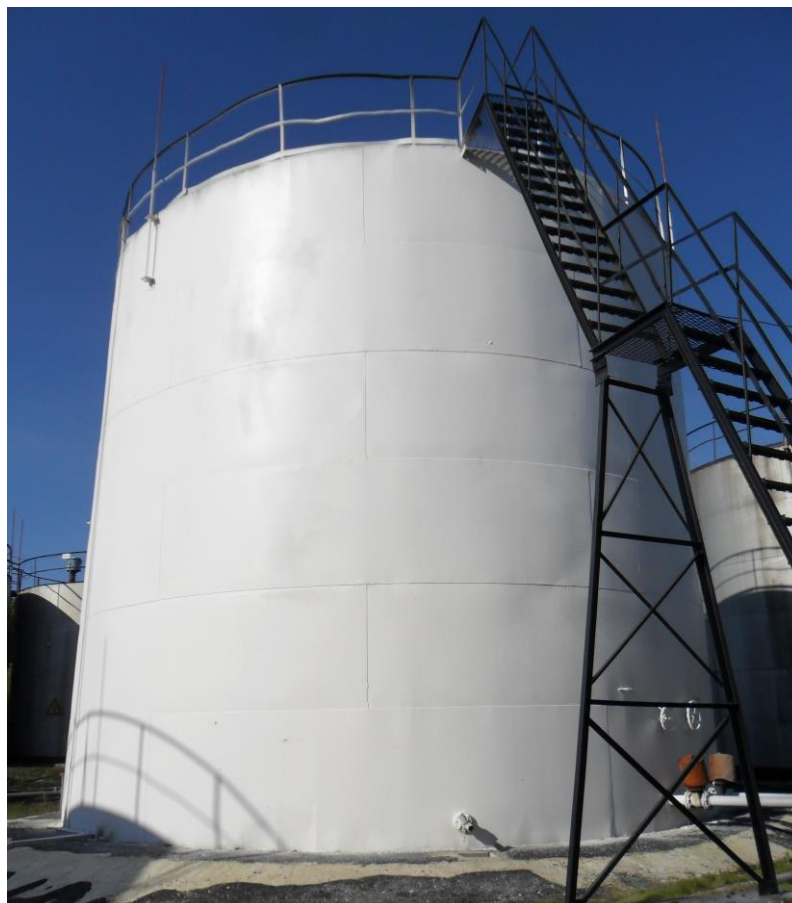
Рисунок 2 – Общий вид резервуаров стальных вертикальных цилиндрических РВС-700
