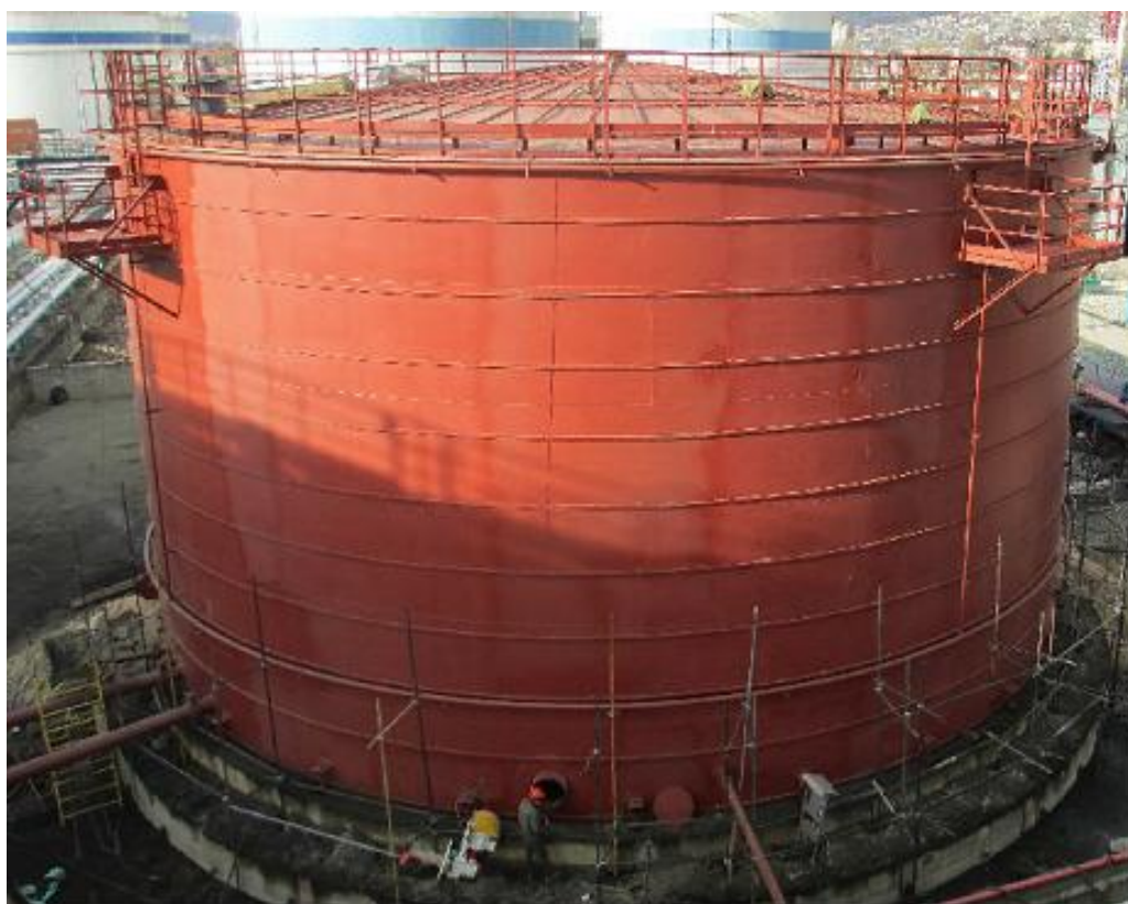
Рисунок 1- Общий вид резервуара
