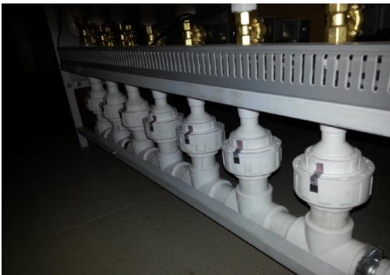
Рисунок 4 - Пломбирования мест установки сопел
