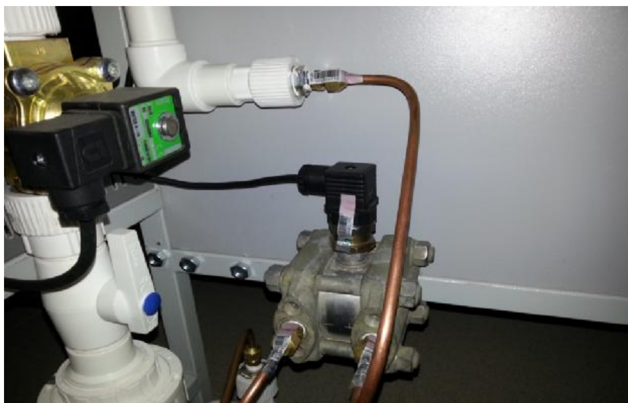
Рисунок 2 - Пломбирования датчика разности давления
