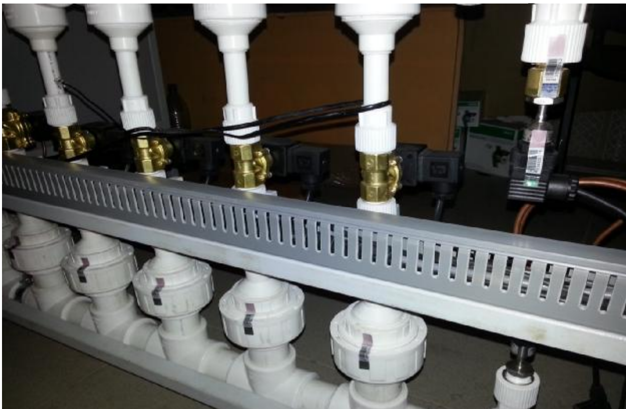
Рисунок 3 - Пломбирования датчика температуры
