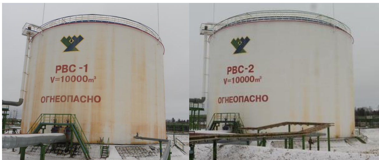
Рисунок 1 – Общий вид резервуаров стальных вертикальных цилиндрических РВС-10000, заводские номера 1, 2
