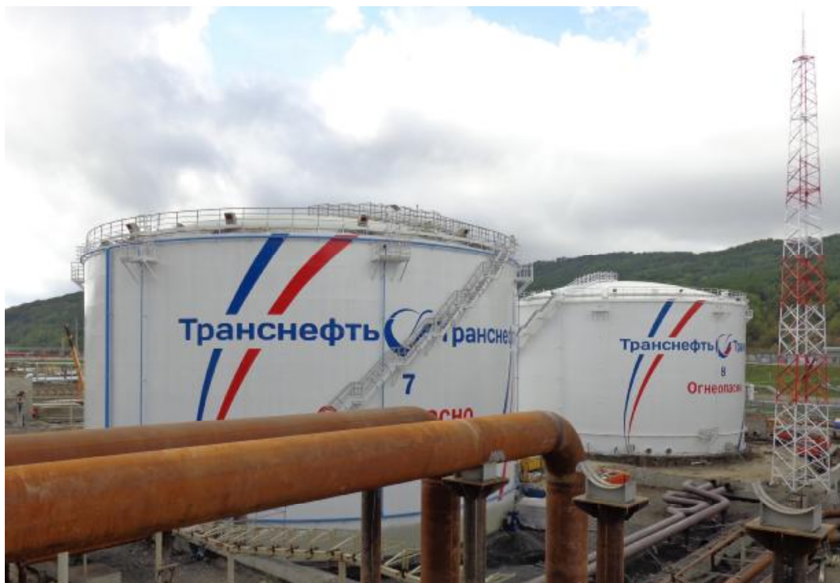
Рисунок 1 - Общий вид резервуаров № 7, 8
