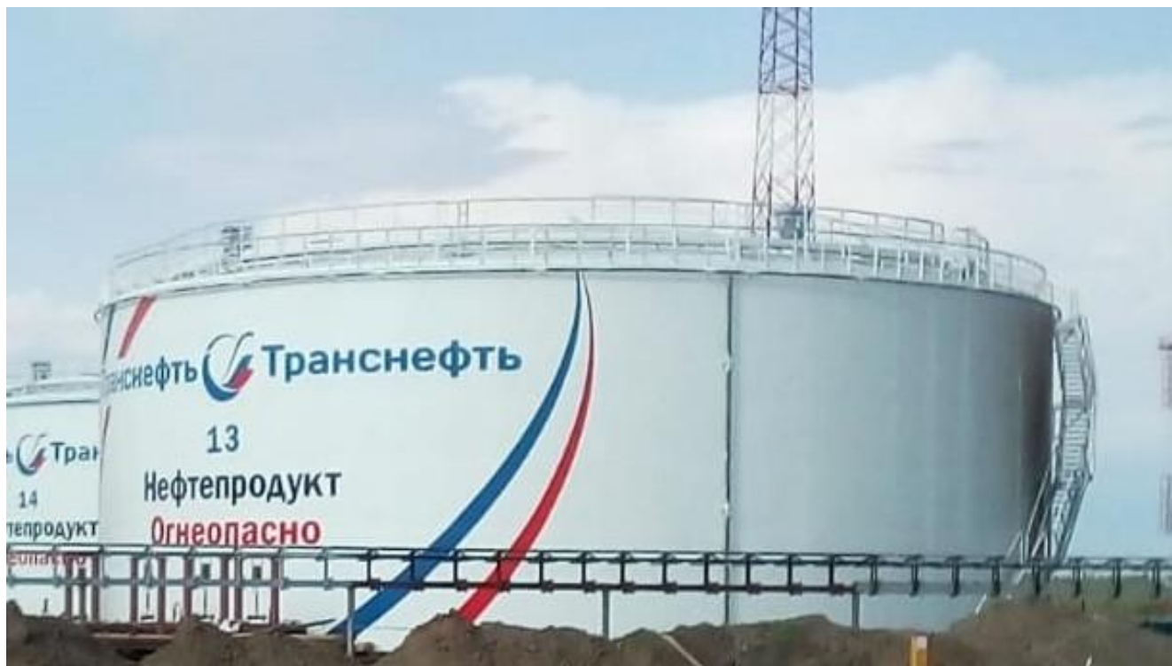
Рисунок 1 – Общий вид резервуаров РВС-10000
