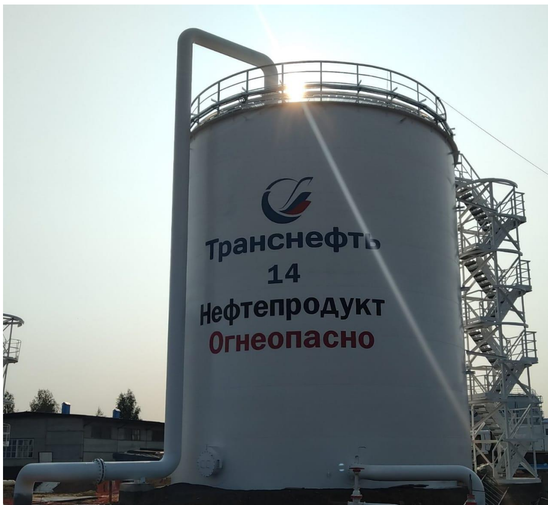
Рисунок 1 – Общий вид резервуара РВС-1000
