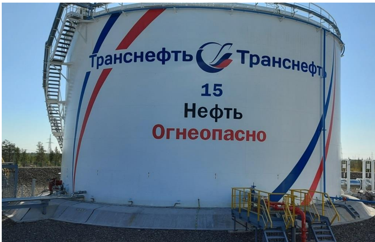
Рисунок 1 – Общий вид резервуаров РВС-5000
