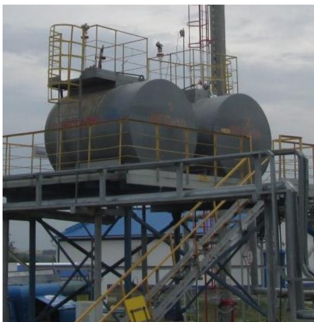
Рисунок 1 – Общий вид резервуаров РГС-10 зав.№ 35, зав.№ 36
