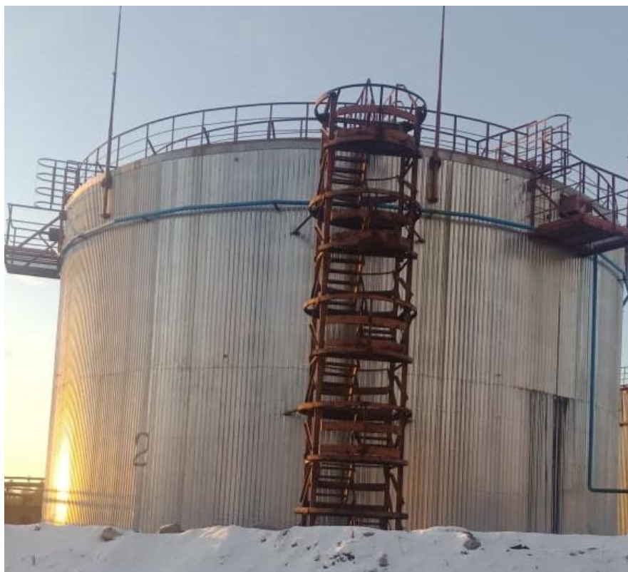
Рисунок 1 – Общий вид резервуара РВС-3000
