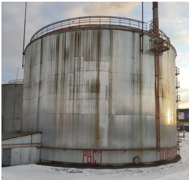
Рисунок 1 – Общий вид резервуара PBC-10000
