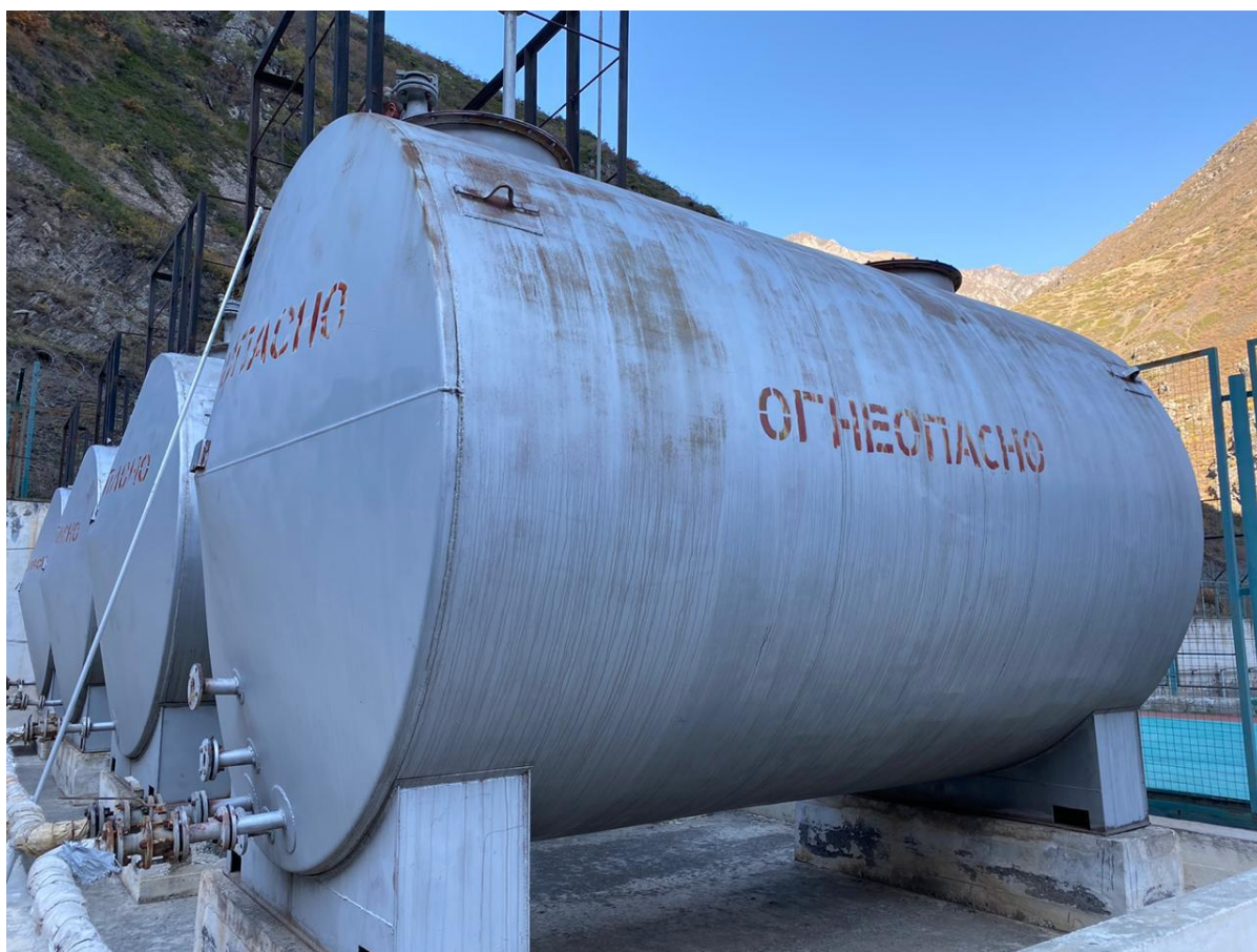
Рисунок 6 – Общий вид резервуаров РГС-25 зав.№№ 24, 33, 34, 35
