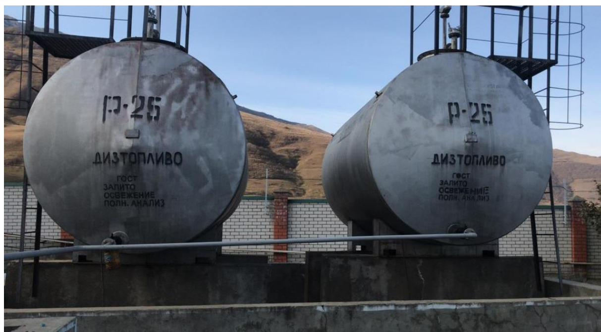
Рисунок 5 – Общий вид резервуаров РГС-25 зав.№№ 31, 54, 57
