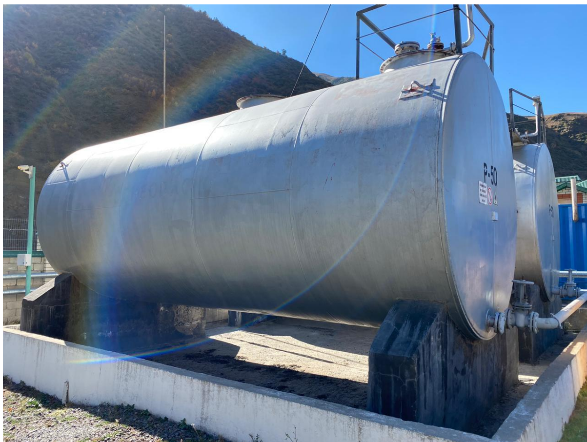
Рисунок 3 – Общий вид резервуаров РГС-50 зав.№№ 88, 89
