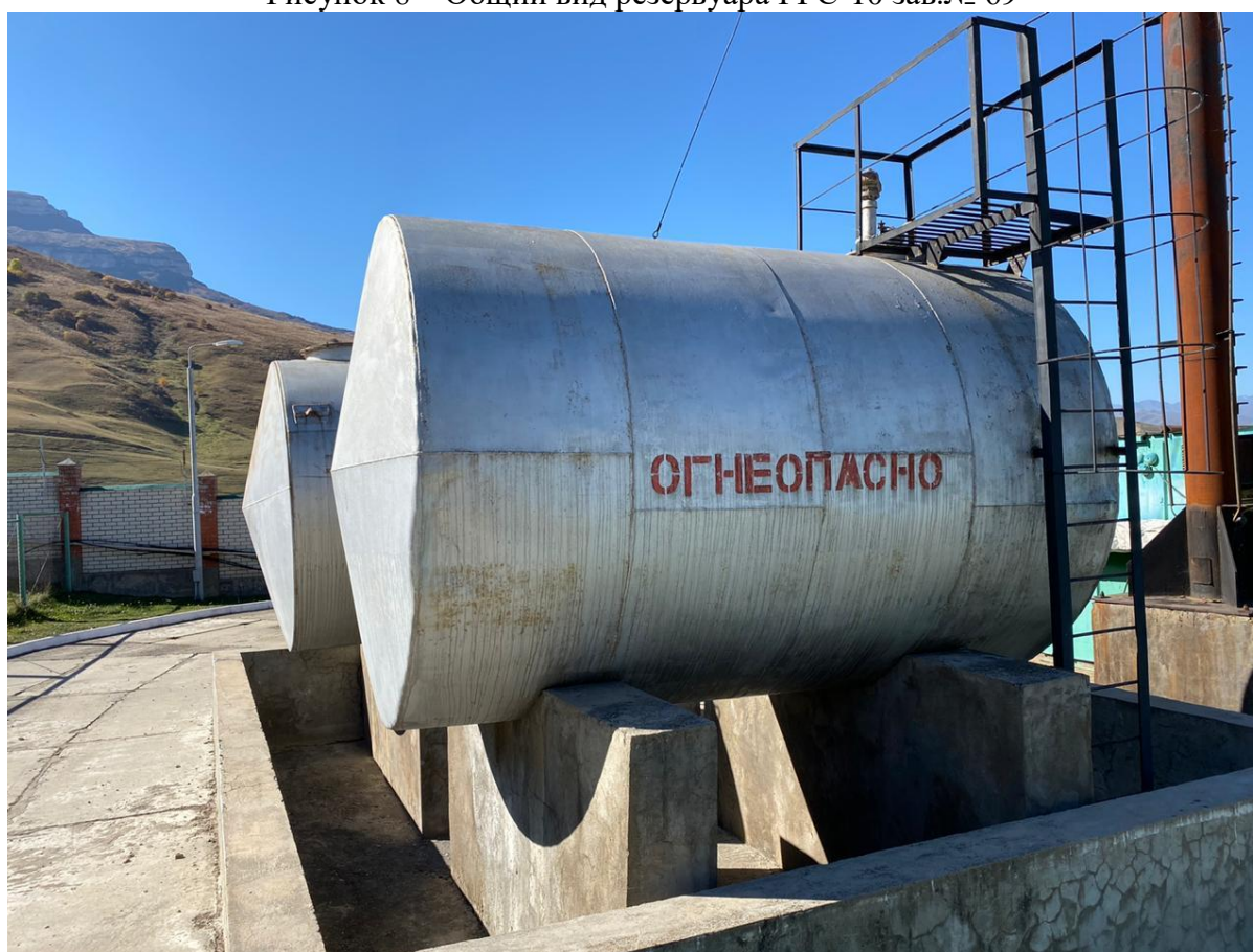
Рисунок 9 – Общий вид резервуаров РГС-25 зав.№№ 65, 66, 67, 68
