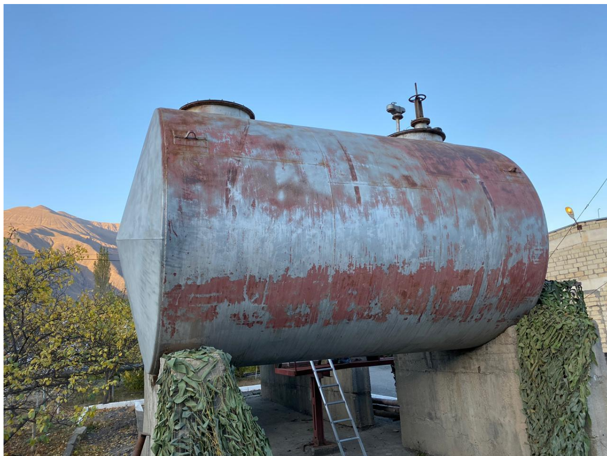
Рисунок 1 – Общий вид резервуара РГС-25 зав.№ 61
