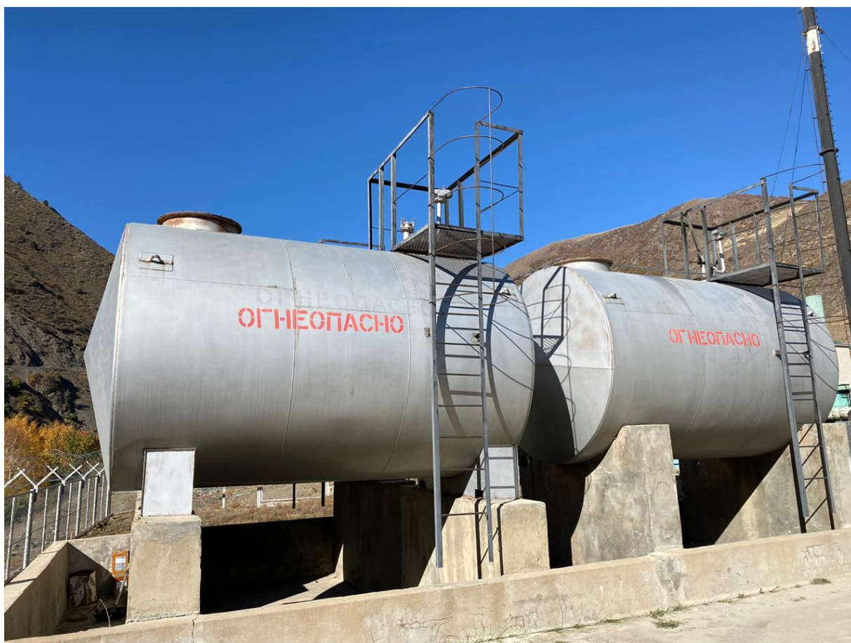
Рисунок 4 – Общий вид резервуаров РГС-25 зав.№№ 23, 36, 37, 40
