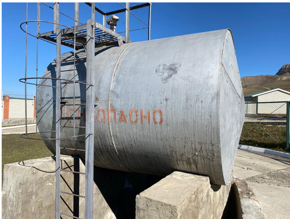
Рисунок 8 – Общий вид резервуара РГС-10 зав.№ 69
