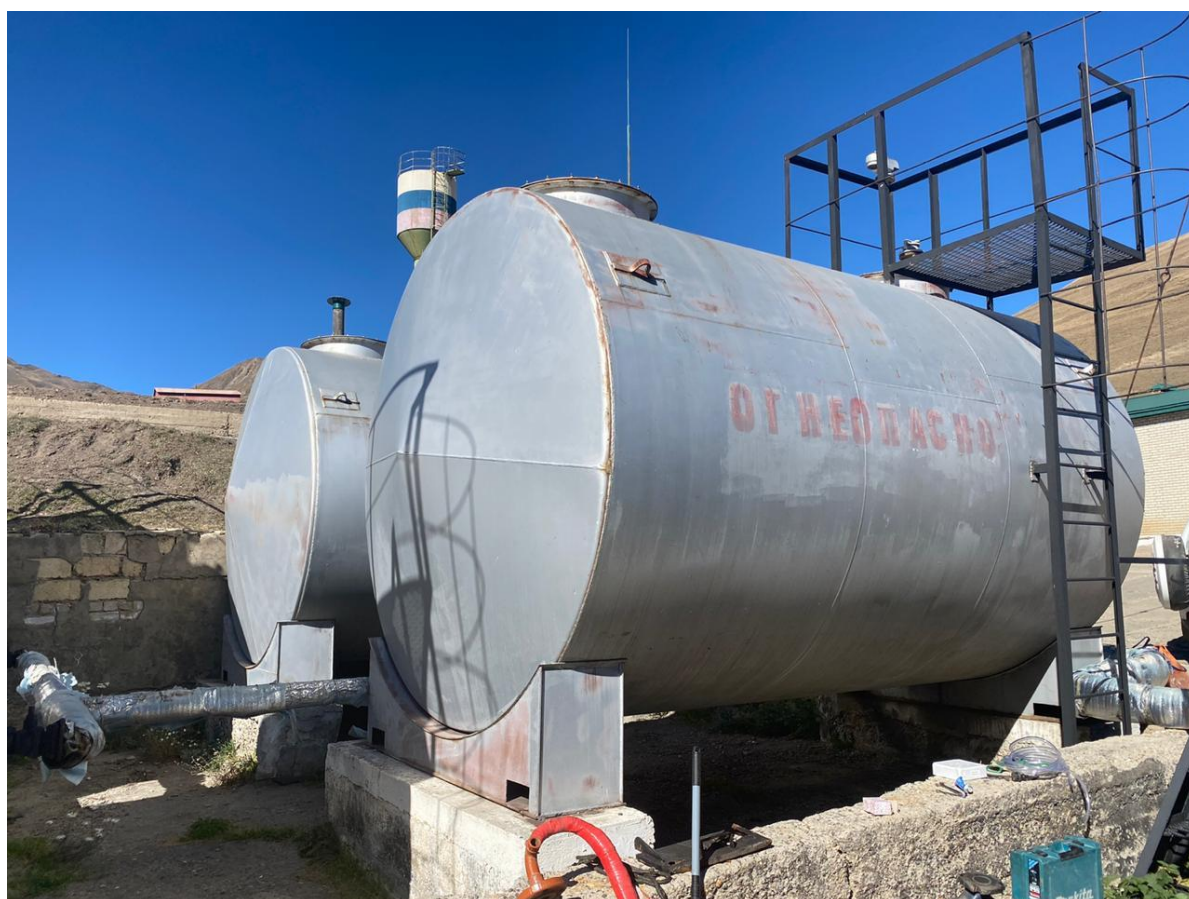
Рисунок 7 – Общий вид резервуаров РГС-25 №№ 10, 61/1
