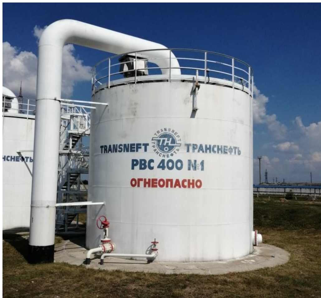
Рисунок 1 – Общий вид резервуаров РВС-400
