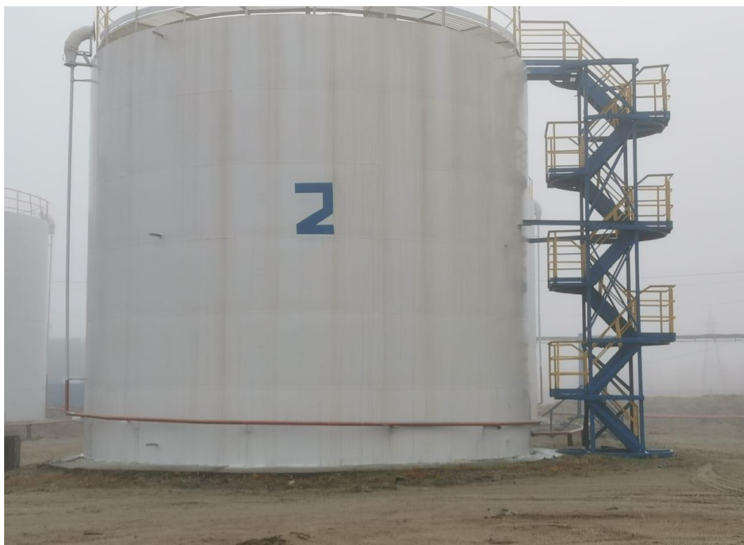
Рисунок 1 – Общий вид резервуара РВС-700
