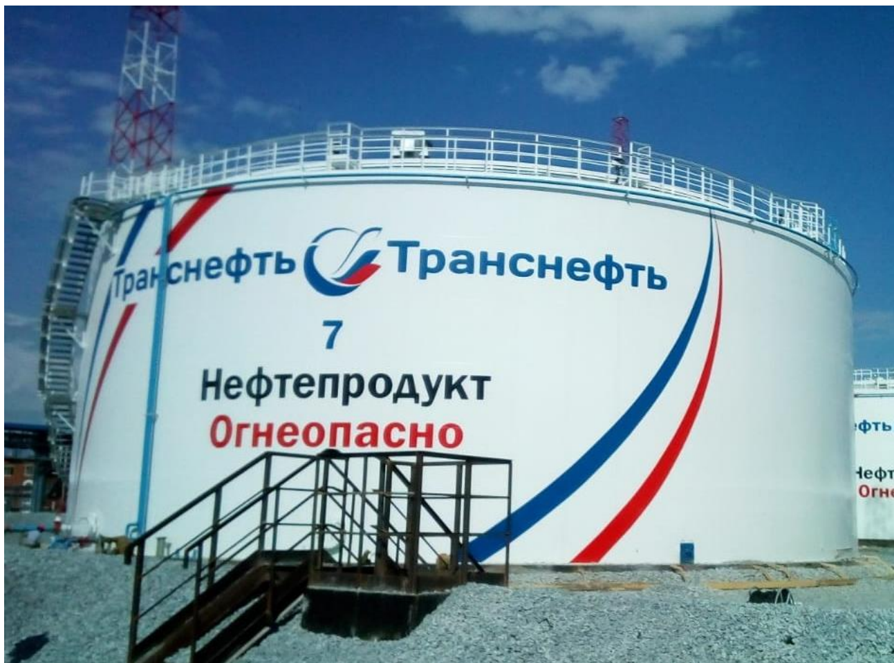
Рисунок 1 – Общий вид резервуаров РВС-10000
