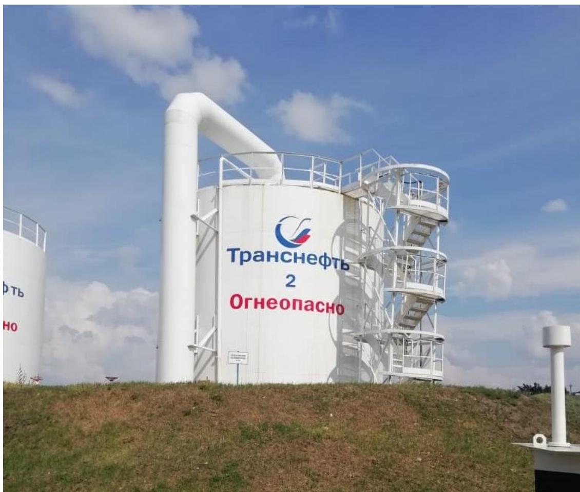
Рисунок 1 – Общий вид резервуаров РВС-400
