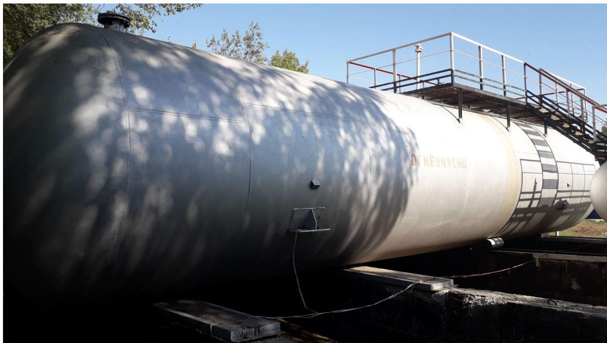
Рисунок 1 – Резервуар горизонтальный РГ-100
