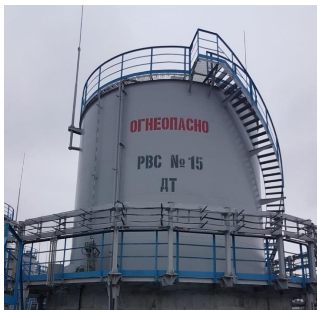
Рисунок 1 – Общий вид резервуаров
