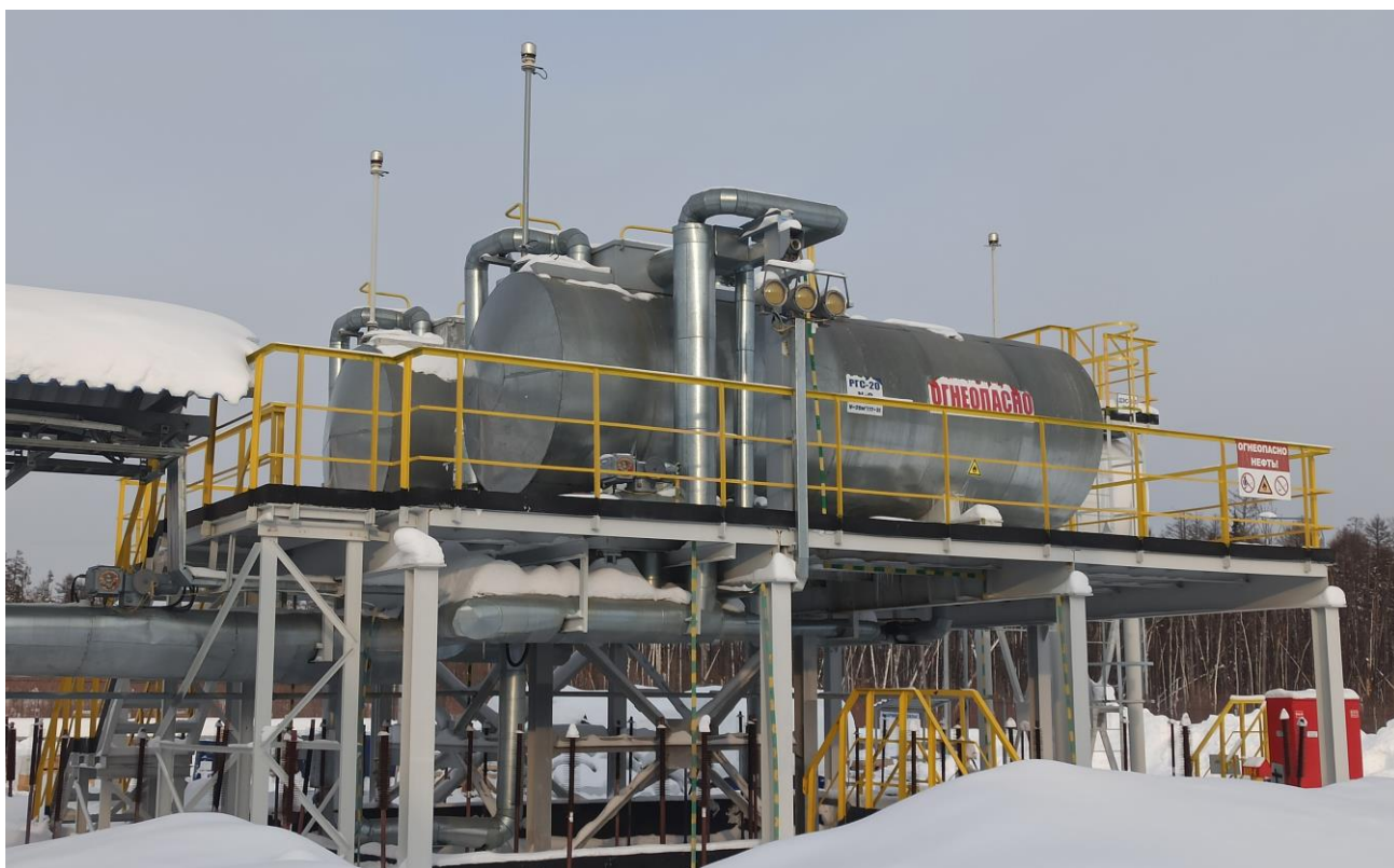
Рисунок 1 – Общий вид резервуаров РГС-20 зав.№№ 127, 128, 157, 159, 125, 126, (1,2), (3,4), 115, 120, 162, 163, 144, 150, 231, 232, 146, 148, 240, 244, 145, 149, 129, 131, 242, 243, 2(Н), 294, 310, 249, 251, 123, 124(124), 143-1/143-2, 147-1/147-2, 300, 301, 1(И), 2(И), 1(Л), 2(Л), 130, 132, 181, 182
