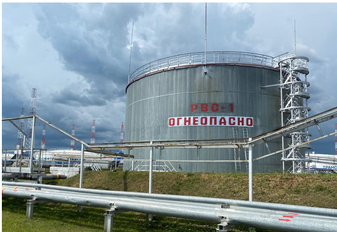
Рисунок 1 – Общий вид резервуара РВСП-5000
