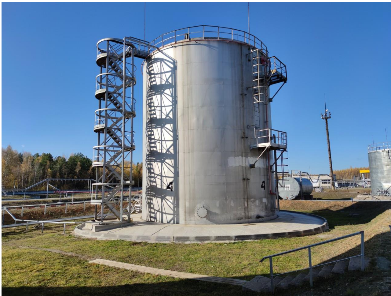
Рисунок 1 – Общий вид резервуара вертикального стального цилиндрического РВС-1000
