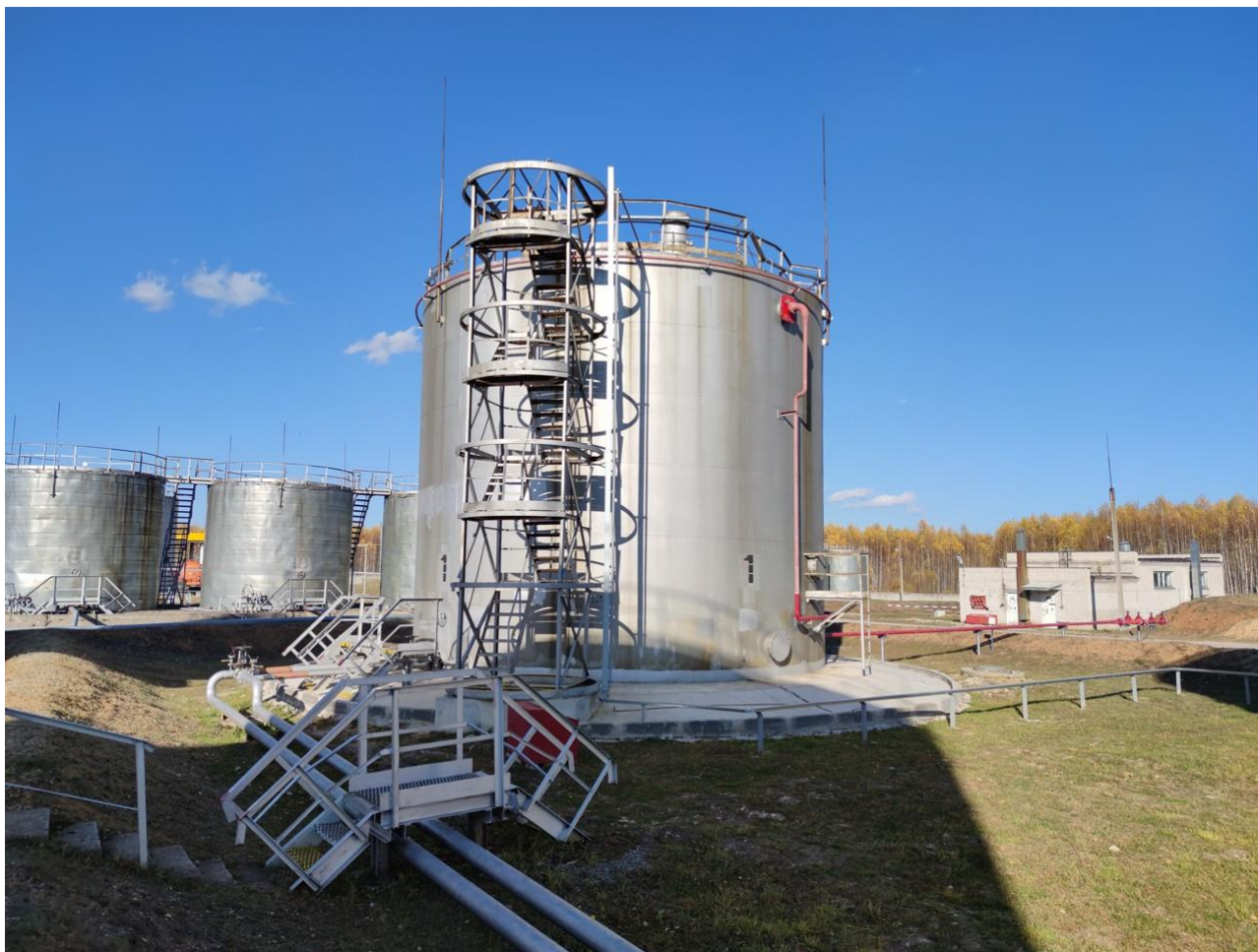
Рисунок 2 – Общий вид резервуара вертикального стального цилиндрического РВСП-700
