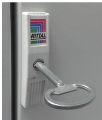
Рисунок 23 – Замок и ключ шкафа кроссового ПС-П. Вид внешний
