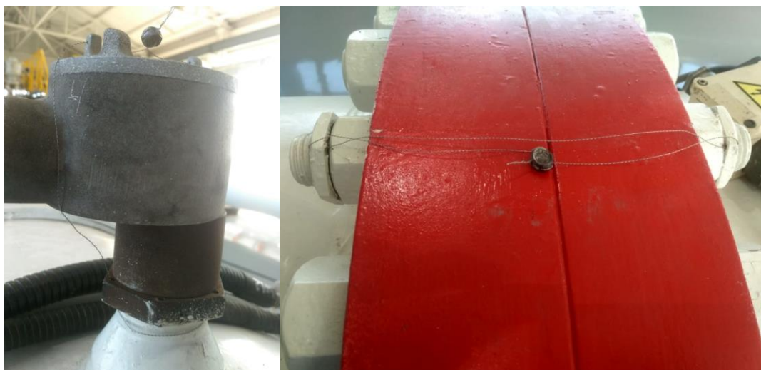
Рисунок 2 – Схема пломбировки детекторов и фланцевых соединений
